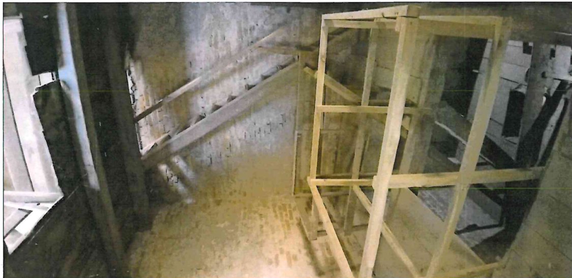
Remont – wymiana desek podłogowych, naprawa schodów, poręczy belek stropowych
