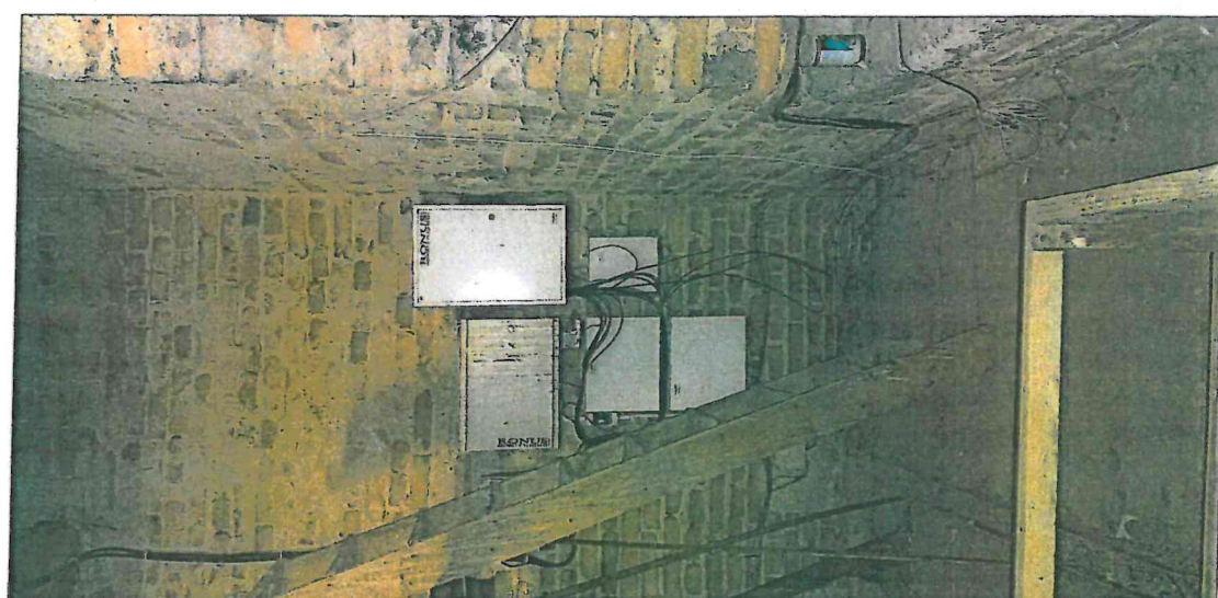
UPORZĄDKOWANIE SYSTEMU OKABLOWANIA WPROWADZENIE DODATKOWYCH SZYN PROWADZĄCYCH
