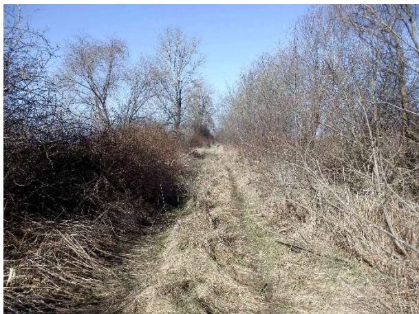
Fot. 1. Droga w złym stanie technicznym, obręb Janków
