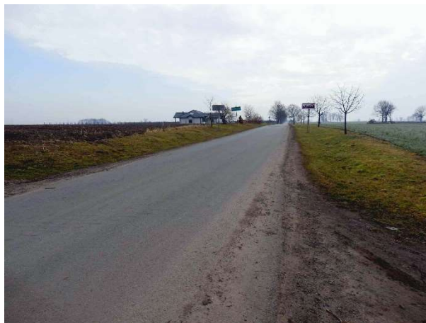
Fot. 2. Droga w dobrym stanie technicznym w obrębie Radłowice
