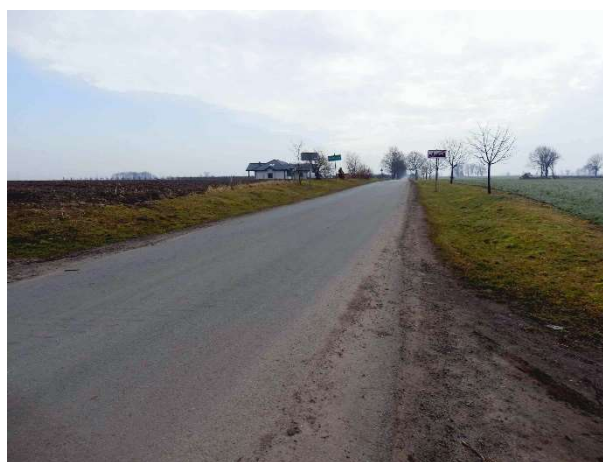
Fot. 24. Droga w dobrym stanie technicznym w obrębie Radłowie
