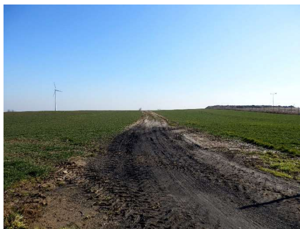
Fot. 47. Droga przeznaczona do modernizacji, biegnąca we wschodniej części wsi Pełczyce
