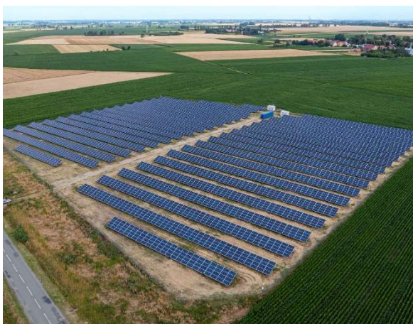
Fot. 32. Elektrownia fotowoltaiczna w Piskorzowie
