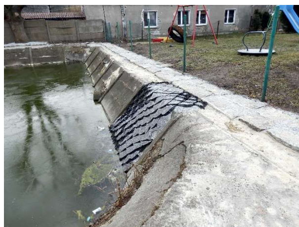
Fot. 45. Zbiornik w trakcie modernizacji w Radłowicach
