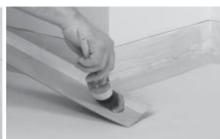
Nanieś klej na podłogę i ścianę między tymi liniami.
