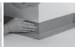
Zamontować listwy HSLA. Solidnie docisnąć
