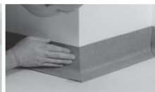
Zamontować listwy HSLA. Solidnie docisnąć
