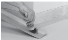
Nanieść klej na podłogę i ścianę między tymi liniami.
