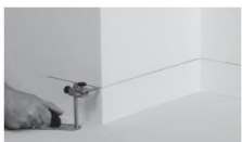
Nanieść linię, do której wykładzina ma być wyłożona na ścianę.
