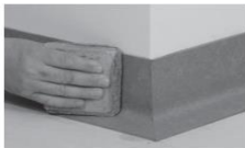
Listwy należy dociskać solidnie, przecierając je w miarę przykładania do powierzchni.
