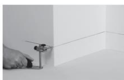
Nanieś linię, do której wykładzina ma być wyłożona na ścianę.
