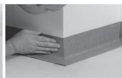
Zamontować listwy HSLA. Solidnie docisnąć.
