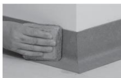
Listwy należy dociskać solidnie, przecierając je w miarę przykładania do powierzchni.
