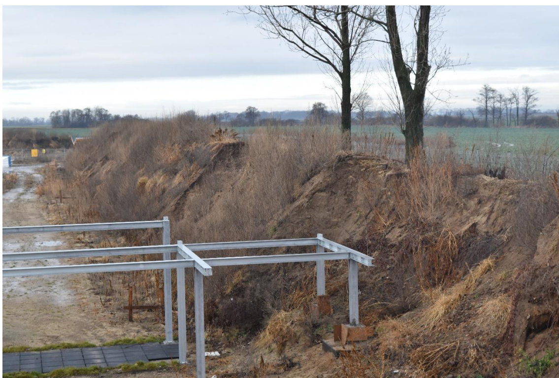
Fot. Obwałowania, stan istniejący 29.12.2021 r. Brak korony i części wału.
