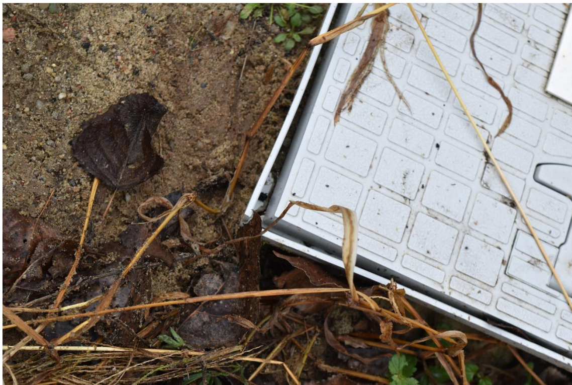
Fot. Skrzynka elektryczna, stan istniejący 29.12.2021 r. Pęknięcie skrzynki elektrycznej.
