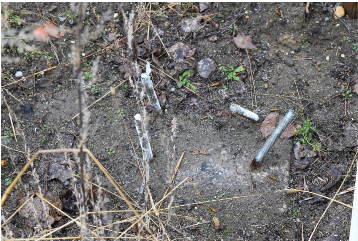
Fot. Fundamenty, stan istniejący 29.12.2021 r. Śruby wygięte i nie zamocowane w osiach
