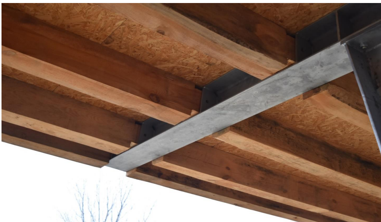
Fot. Kulochwyt główny, stan istniejący 29.12.2021 r. Brak śrub łączących konstrukcję stalową i drewnianą.
