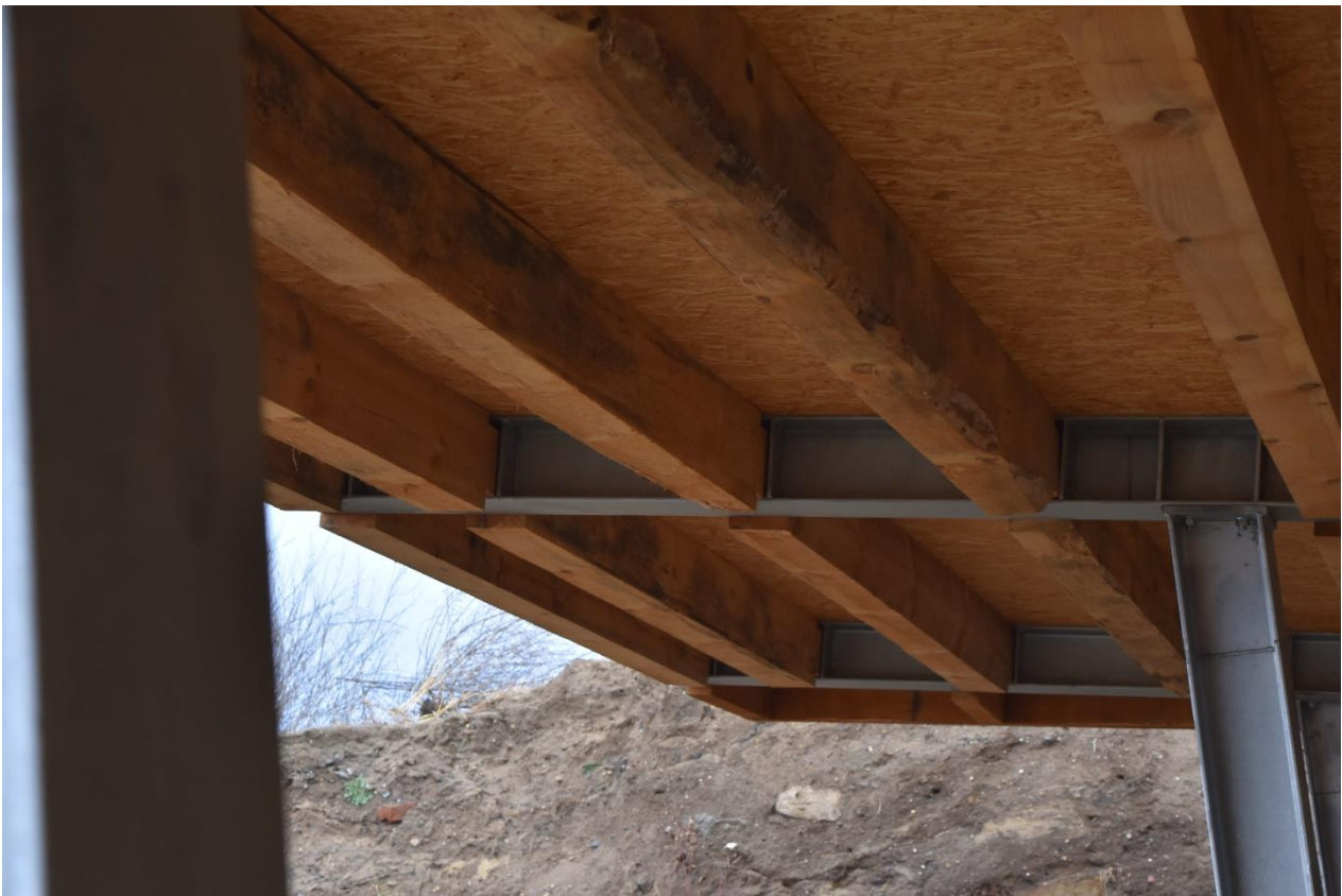
Fot. kulochwyt główny, stan istniejący 29.12.2021 r. Brak śrub łączących konstrukcję stalową i drewnianą.
