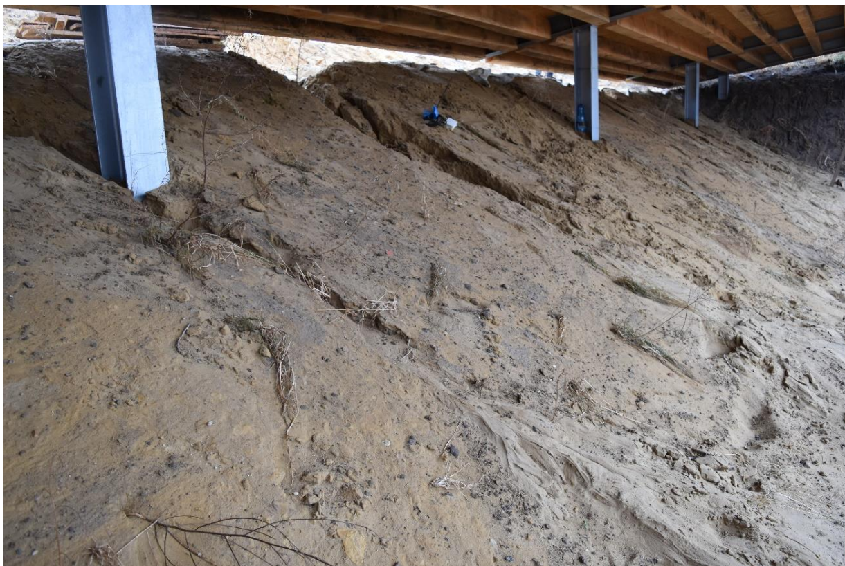
Fot. Kulochwyt główny, stan istniejący 29.12.2021 r. Widoczny przyłącznie elektryczne. Widoczne uszkodzenia kulochwytu od wody opadowej.
