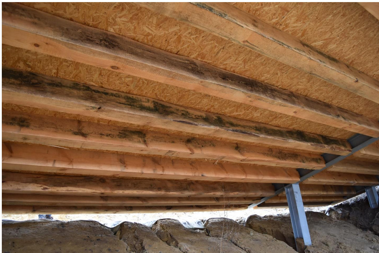
Fot. Kulochwyt główny, stan istniejący 29.12.2021 r. Widoczny grzyb.
