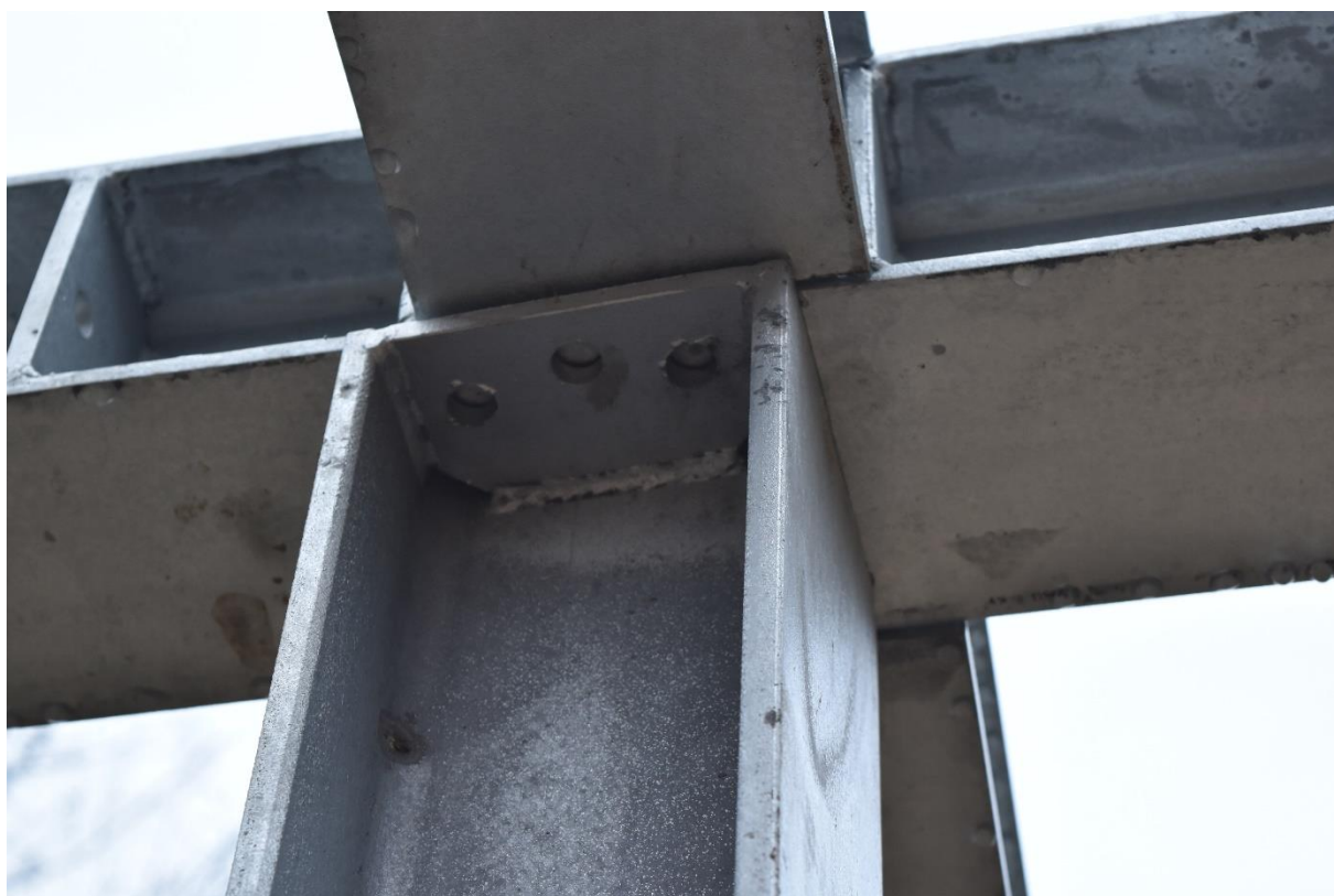
Fot. Konstrukcja stalowa LOO 25 m, stan istniejący 29.12.2021 r. Brak otworów i śrub mocujących.
