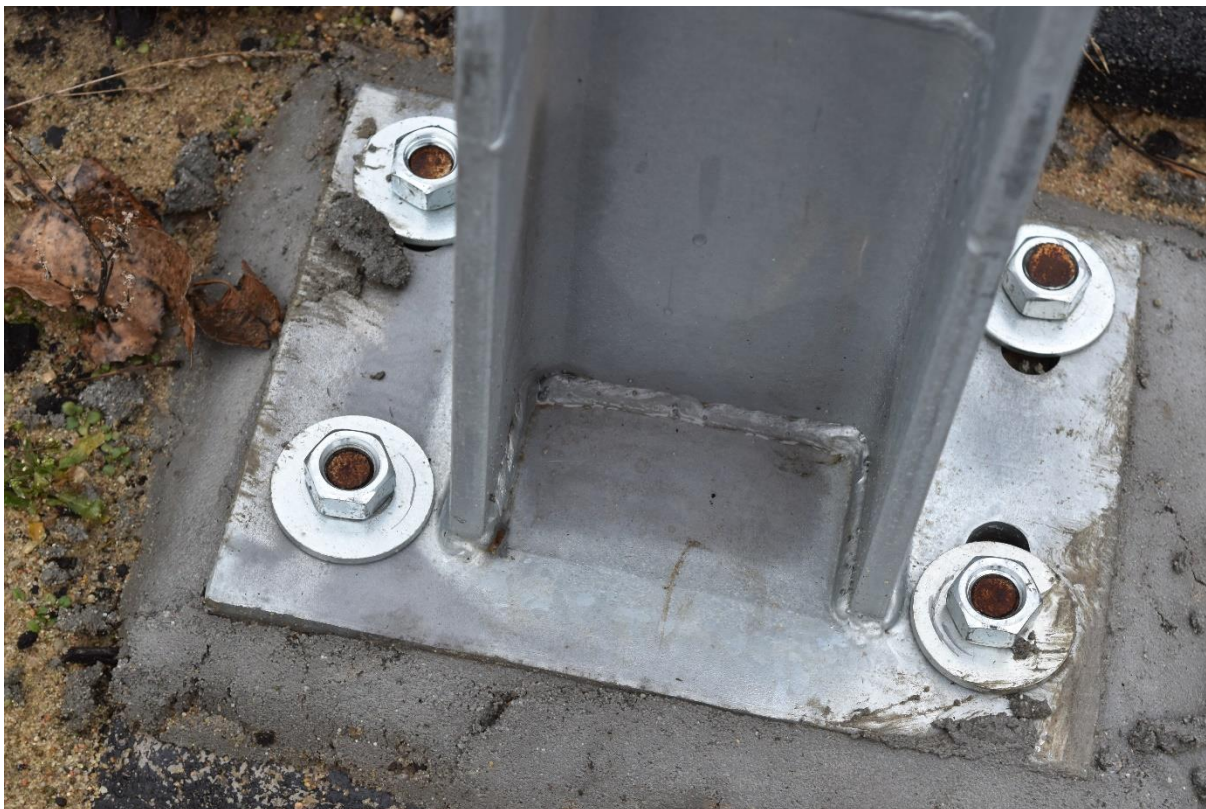
Fot. Konstrukcja stalowa LOO 25 m, stan istniejący 29.12.2021 r. Śruby za krótkie może to grozić wyrwaniem słupa.
