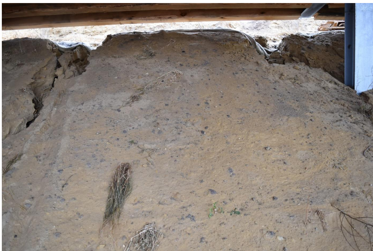
Fot. Kulochwyt główny, stan istniejący 29.12.2021 r. Uszkodzenia kulochwytu.
