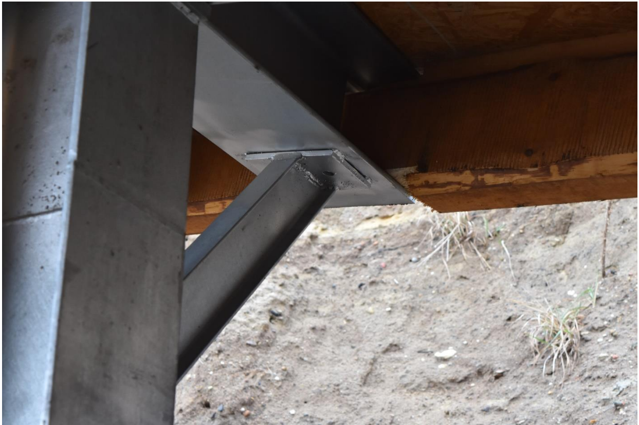
Fot. Kulochwyt główny, stan istniejący 29.12.2021 r. Zmiana połączenia na spawane niezgodnie dokumentacją niewielka długość spawów.
