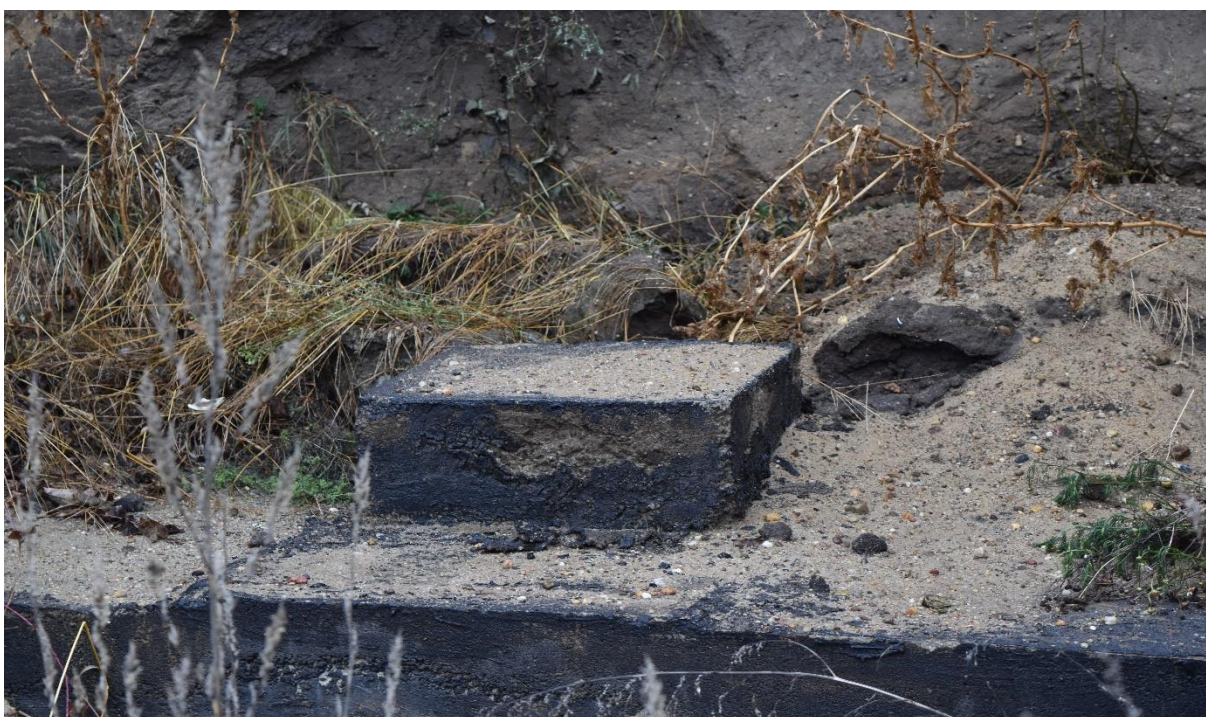
Fot. Fundamenty, stan istniejący 29.12.2021 r. Brak wbetonowanych śrub i widoczne uszkodzenie izolacji.
