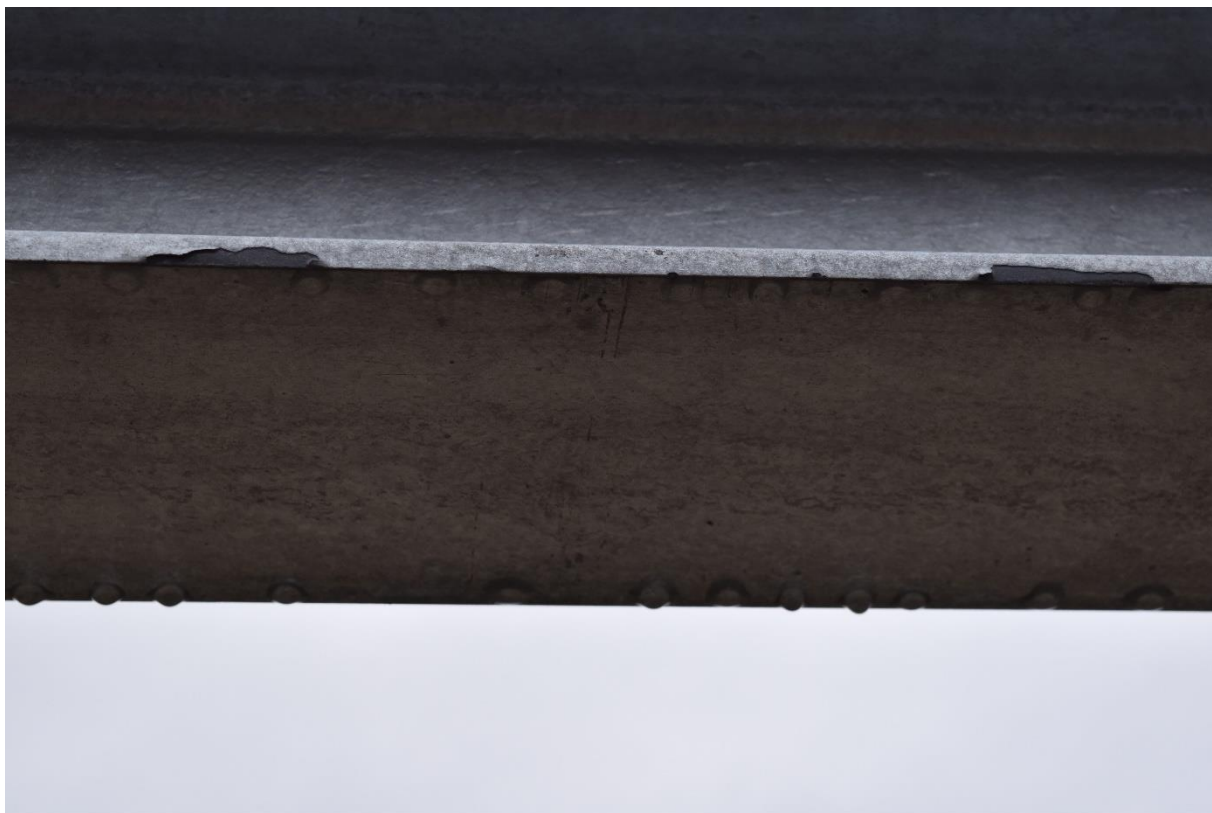
Fot. Stanowisko strzeleckie LOO 25 m, stan istniejący 29.12.2021 r. Widoczne uszkodzenie powłoki cynkowej
