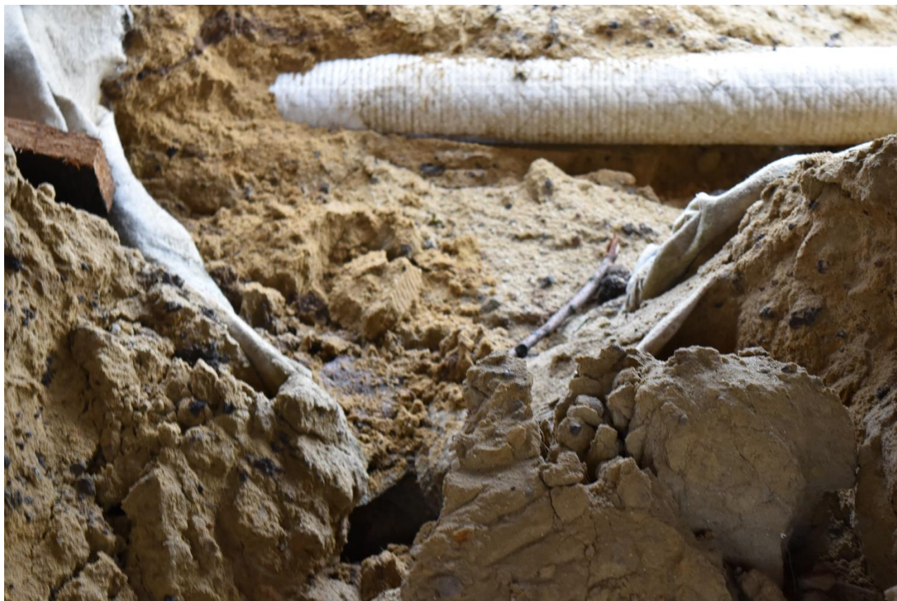
Fot. kulochwyt główny, stan istniejący 29.12.2021 r. Drenaż niezgodny z dokumentacją brak zasypki oraz folii.
