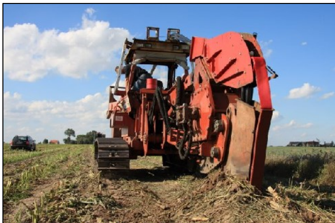
Rycina 27. Sprzęt wykorzystywany do układania kabli metodą plużenia (źródło: http://thomsen.pl )
