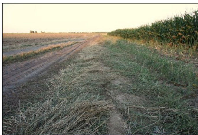
Rycina 28. Wygląd terenu po zakończeniu prac układania kabli metodą plużenia (źródło: http://thomsen.pl )
