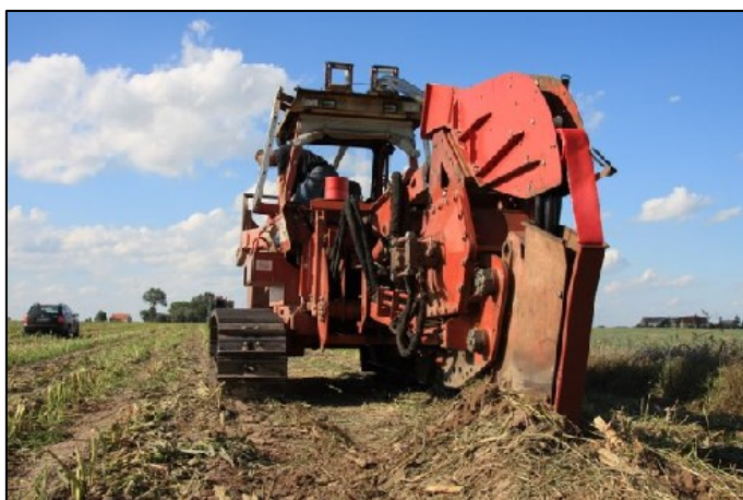
Rycina 23. Sprzęt wykorzystywany do układania kabli metodą plużenia (źródło: http://thomsen.pl )
