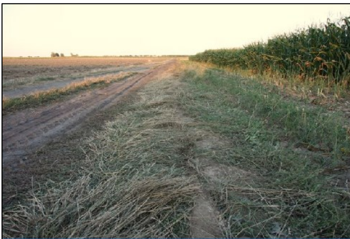
Rycina 24. Wygląd terenu po zakończeniu prac układania kabli metodą plużenia (źródło: http://thomsen.pl )
