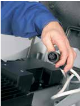
Odkręcenie nakrętek mocujących zasilacz do oprawy oraz odłączenie wtyków zasilających bez użycia narzędzi
