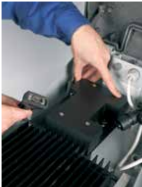
Odkręcenie nakrętek mocujących zasilacz do oprawy oraz odłączenie wtyków zasilających bez użycia narzędzi
