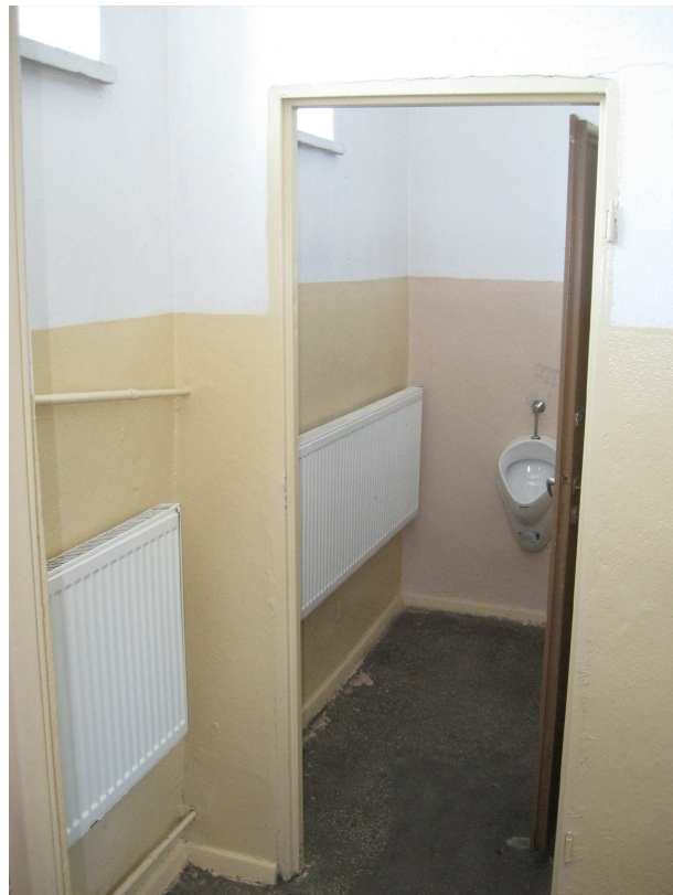
wc na parterze
