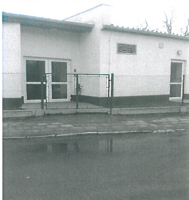
Świetlica wiejska w Kończycach
