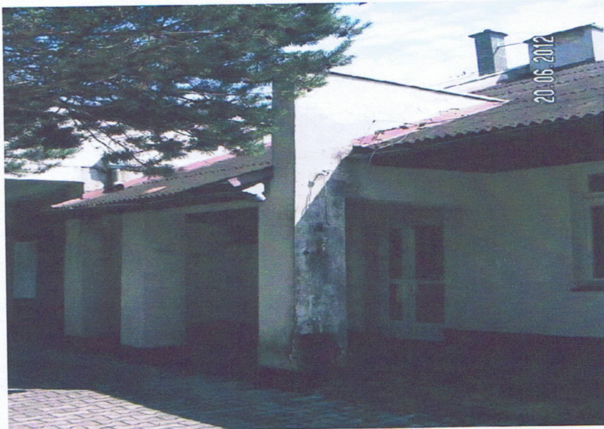
Rys. nr 3 (strona północna, wejście do kotłowni, na zdjęciu widoczny komin przewidziany do tynkowania z pustaków kominowych zespolonych)
