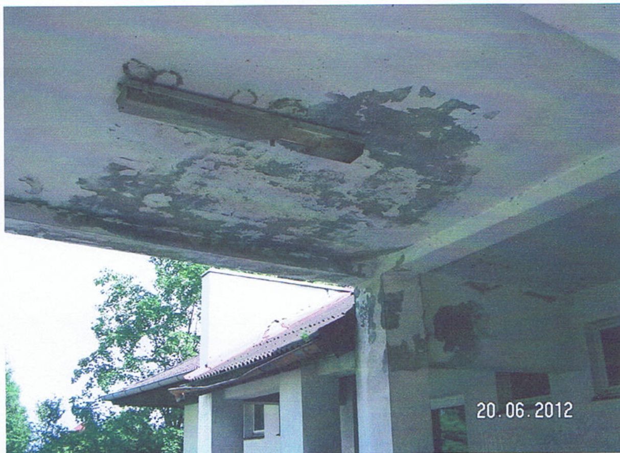
Rys. nr 5 (zadaszenie podjazdu od strony północnej)
