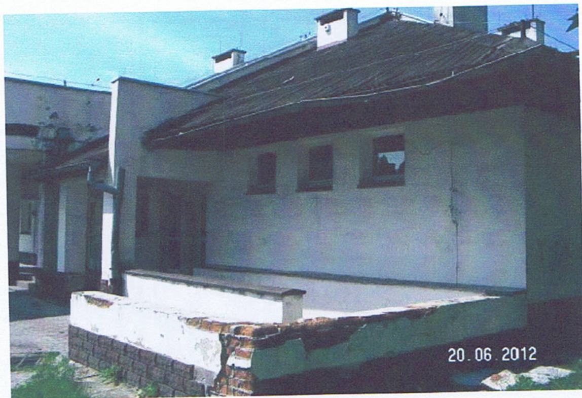
Rys. nr 1 (strona południowa, podjazd dla niepełnosprawnych)
