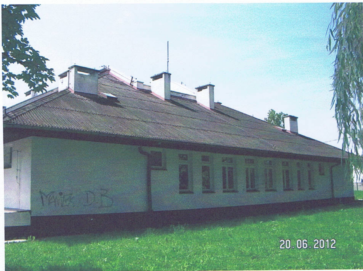
Rys. nr 6 (ściana wschodnia budynku).
