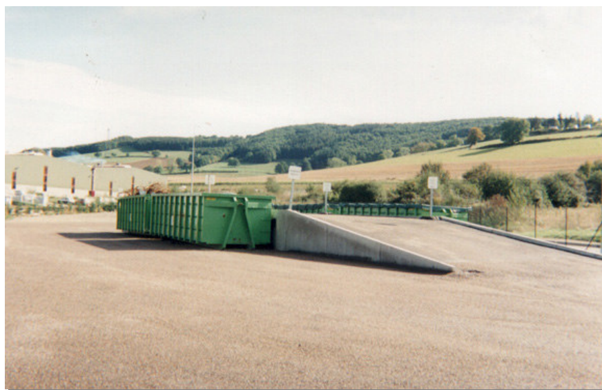
Rys. 9 Rampa wyładownicza zlokalizowana na terenie PDGO
