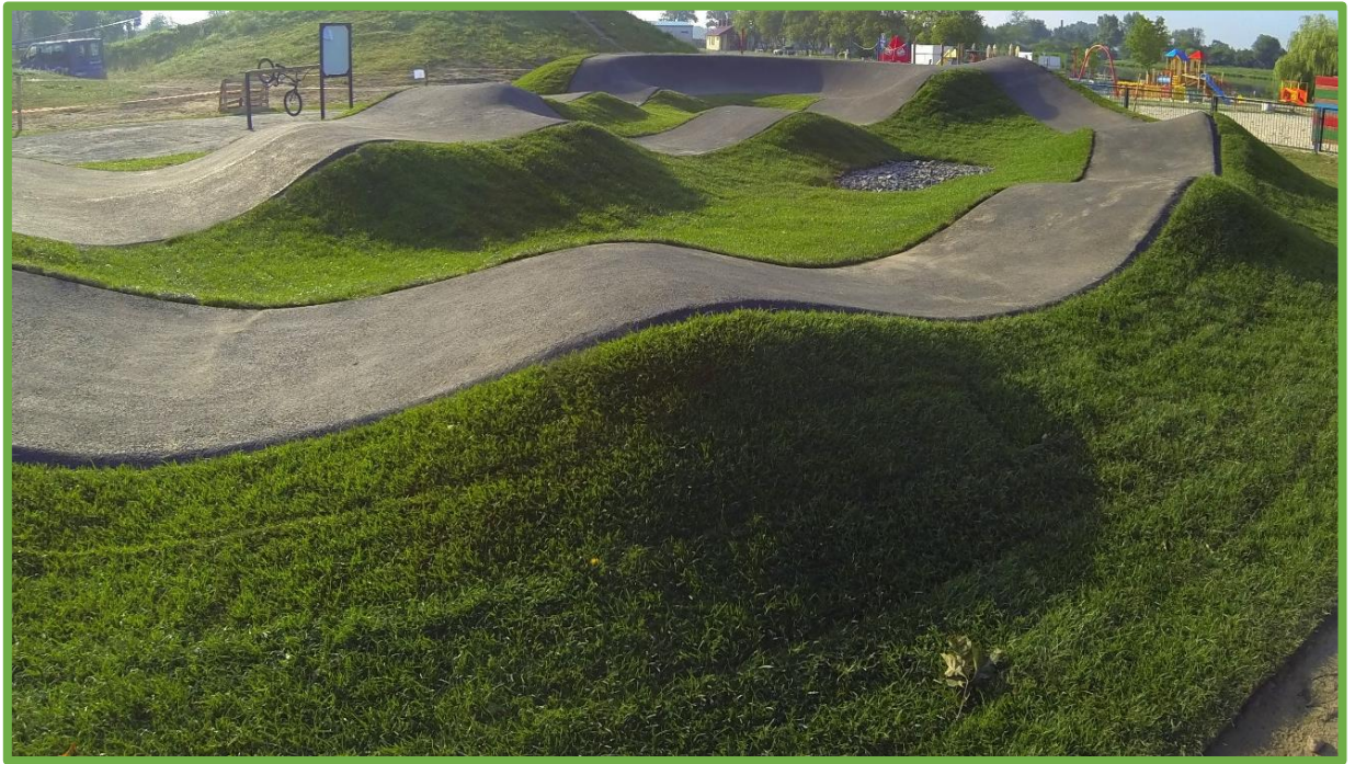
Garby o prawidłowo wyprofilowanych kształtach
