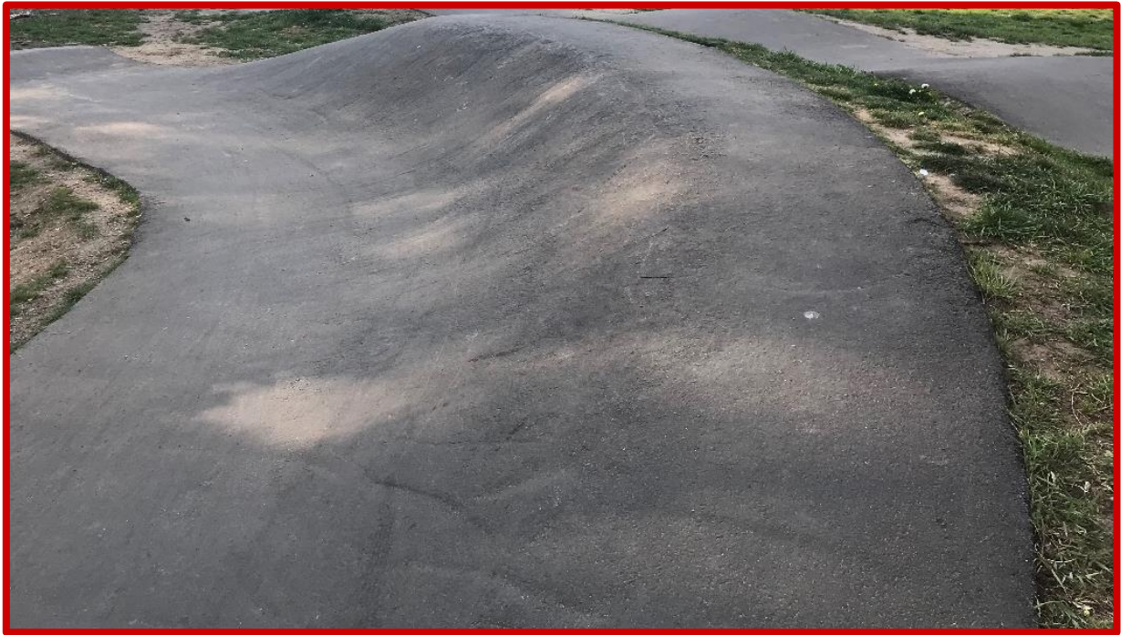
Nieprawidłowa powierzchnia nawierzchnia asfaltowa – nadmiernie chropowata z widocznymi rysami i nierównościami
