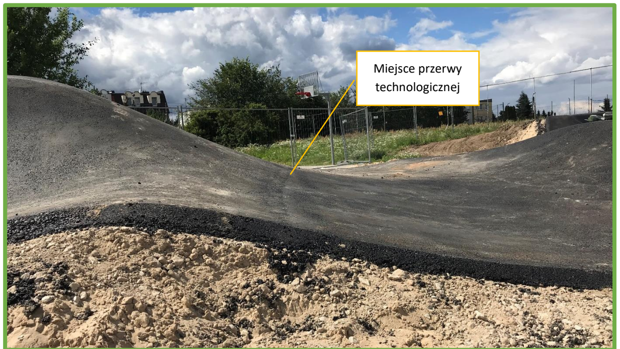
Prawidłowo wykonane połączenia – bez wyczuwalnych uskoków ani zmian profilu przeszkody.
