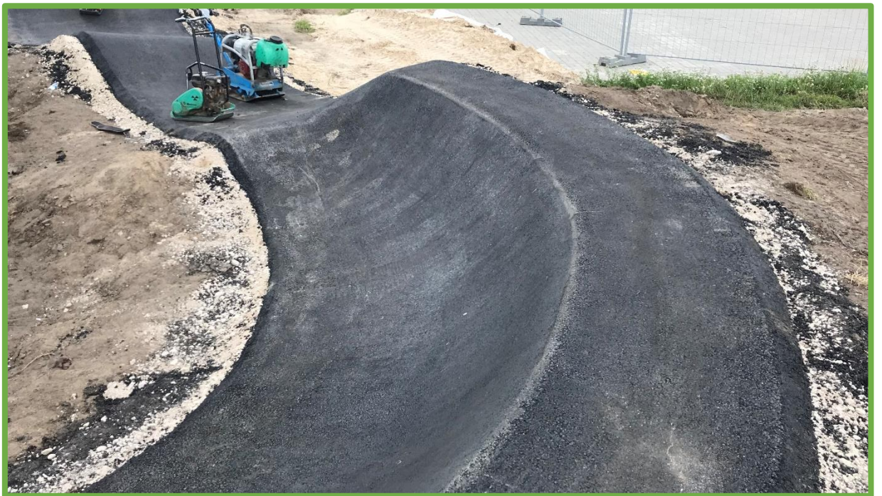
Prawidłowo wykonana nawierzchnia asfaltowa – jednorodna i gładka.
