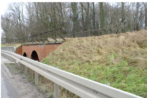
Zabytkowy most kolejowy
