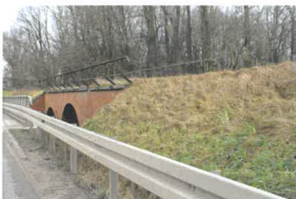
Zabytkowy most kolejowy
