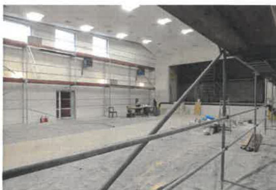
Świetlica wiejska w trakcie remontu
