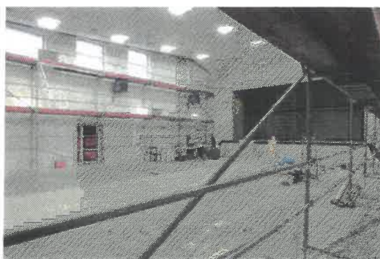
Świetlica wiejska w trakcie remontu
