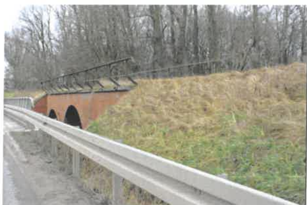
Zabytkowy most kolejowy
