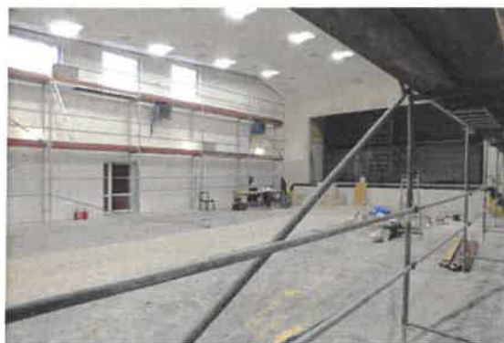
Świetlica wiejska w trakcie remontu
