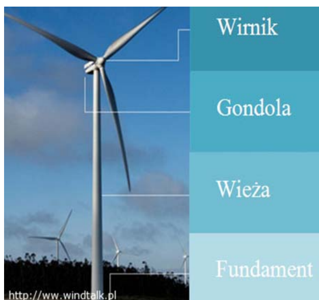
Rysunek: Części elektrowni wiatrowej 16
