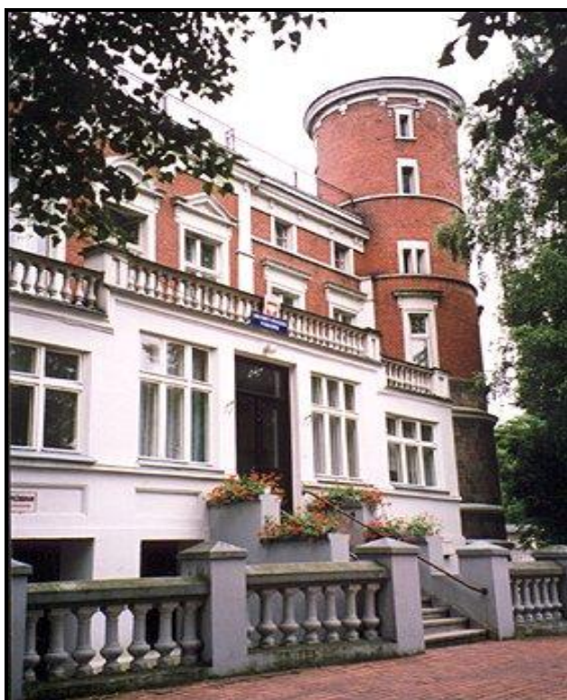
Zdjęcie: Pałac w Fabianowie – fasada frontowa
