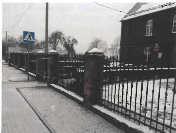
Zdj. Koźminiec, ogrodzenie
