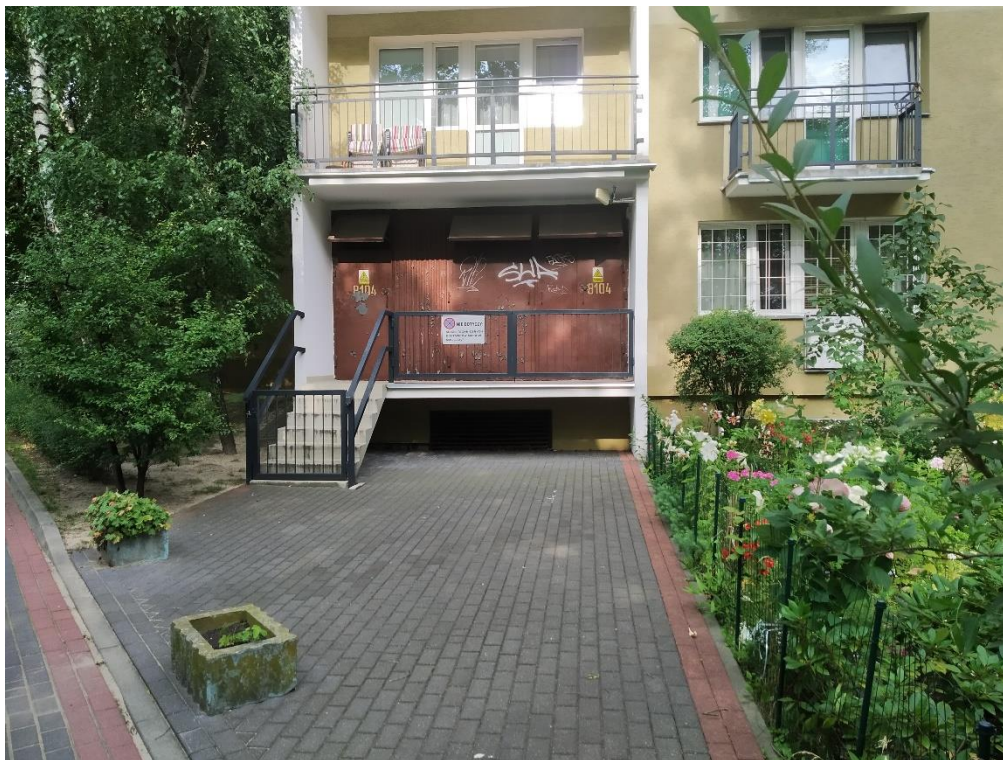
Zdjęcie 3. Stacja elektroenergetyczna nN/SN umieszczona w budynku mieszkalnym wielorodzinnym (źródło: PGE E.O.)
