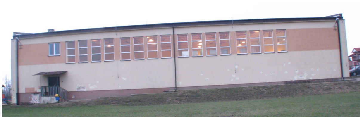
Sala gimnastyczna – str E
