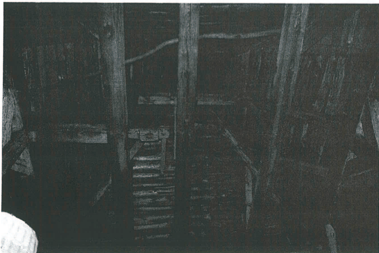
Fot. 3. Więźba dachowa
