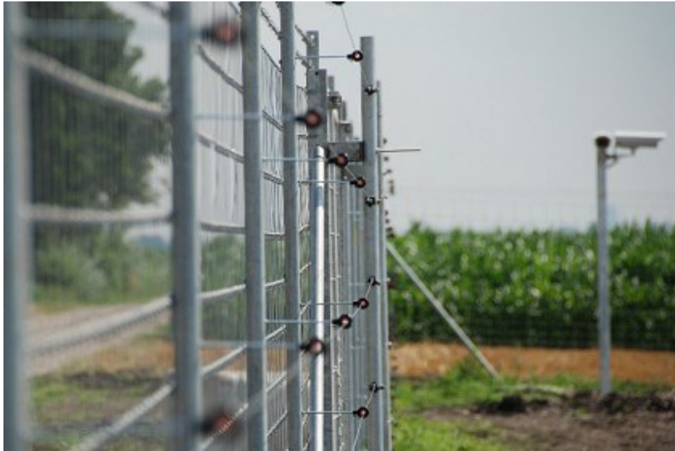
Rysunek 3 Przykładowe ogrodzenie farmy fotowoltaicznej
