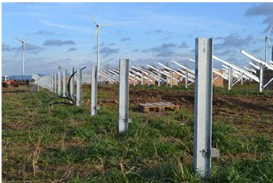
Zdjęcie 1 Profile metalowe: podstawowy element konstrukcji.
