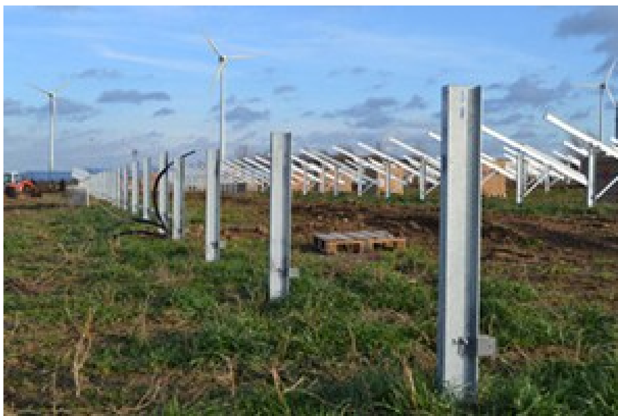
Zdjęcie 1 Profile metalowe: podstawowy element konstrukcji.
