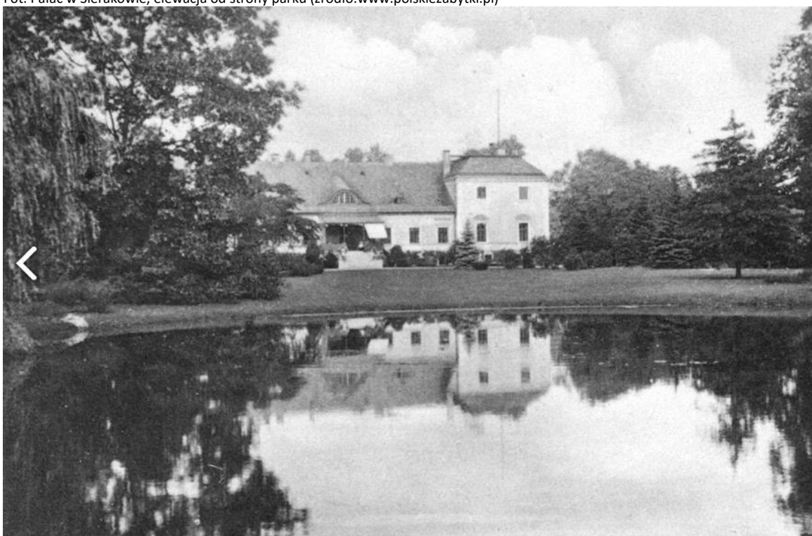
Fot. Pałac w Sierakowie, elewacja od strony parku (źródło:www.polskiezabytki.pl)
