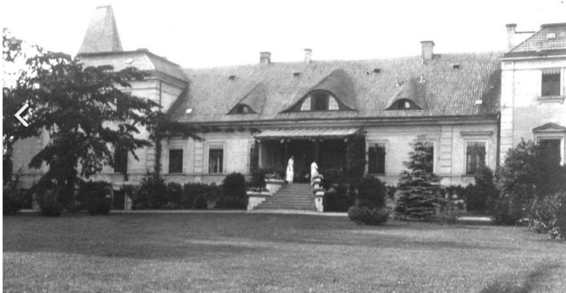
Fot. Pałac w Sierakowie, elewacja od strony parku (źródło:www.polskiezabytki.pl)
