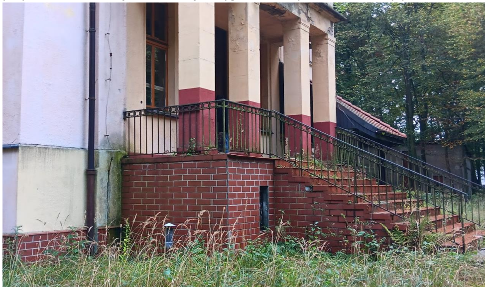
Klinkierowa okładzina schodów i muru pod tarasem przy elewacji północnej.
