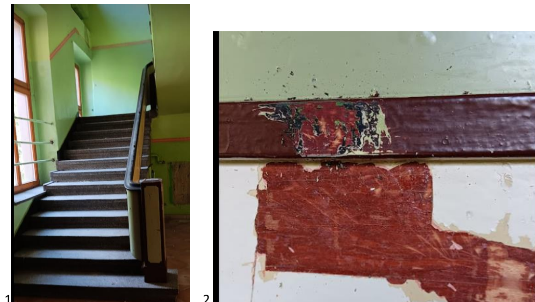
Główna klatka schodowa ( 1) oraz detal balustrady z odkrywką , pokazującą historyczną kolorystykę.
