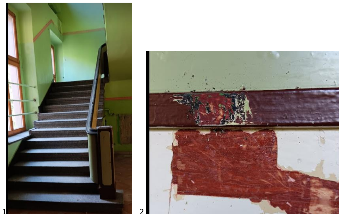
Główna klatka schodowa ( 1) oraz detal balustrady z odkrywką , pokazującą historyczną kolorystykę.
