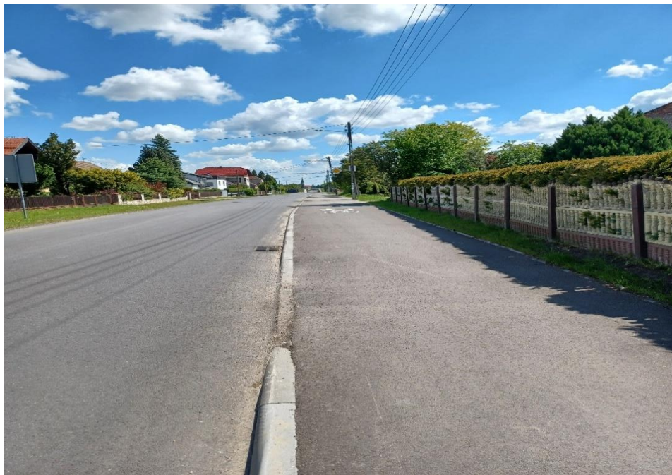
Zdjęcie: Wybudowana droga pieszo-rowerowa przy ul. Wyzwolenia w Sierakowie Śląskim.
