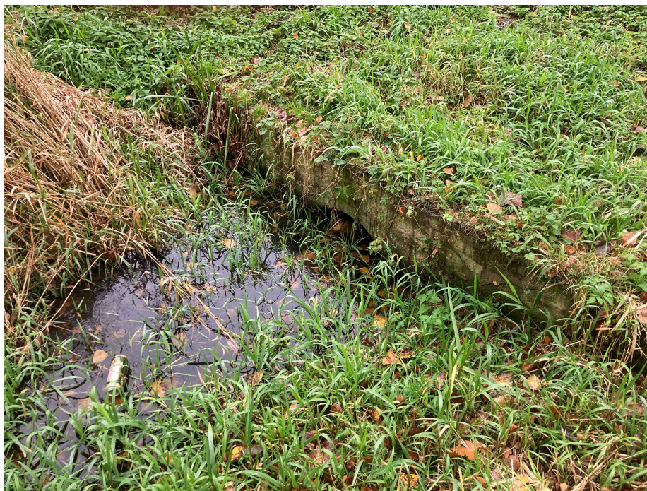
ZDJĘCIE NR 3. WLOT WODY DO ROWU OPASKOWEGO.
