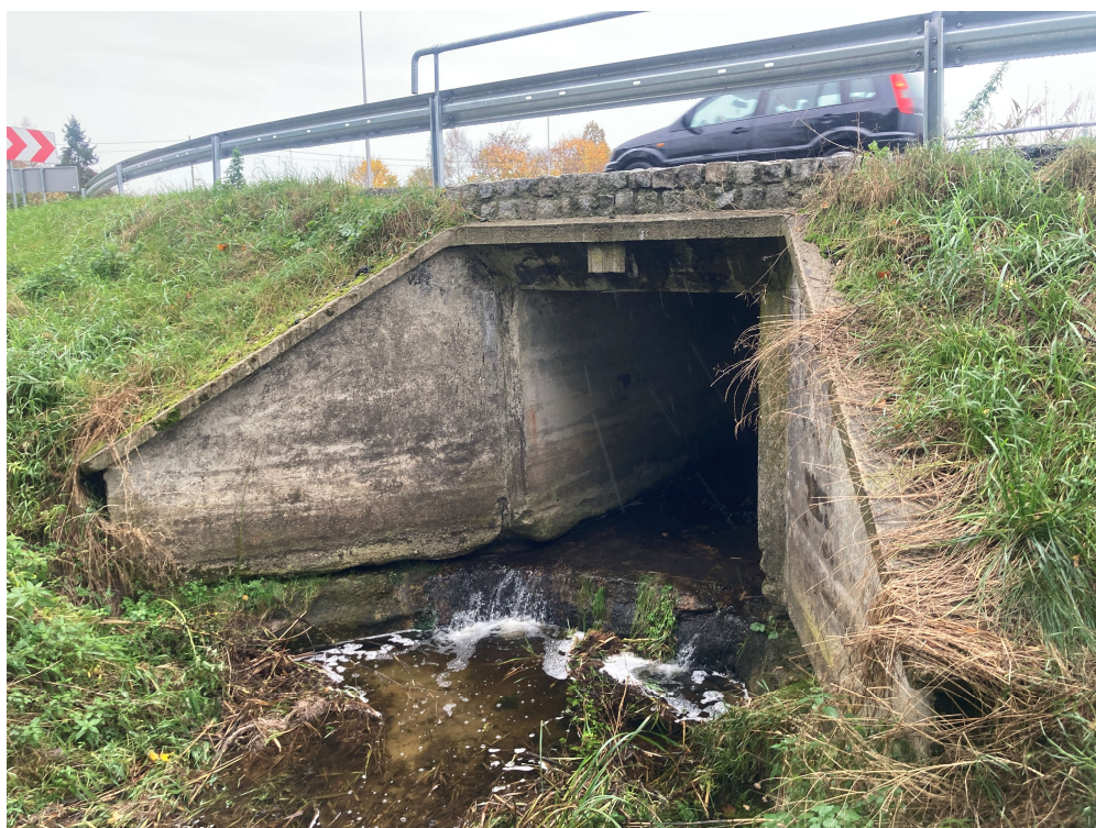
ZDJĘCIE NR 4. WYŁOT Z ZASTAWKI DO ROWU I-1
