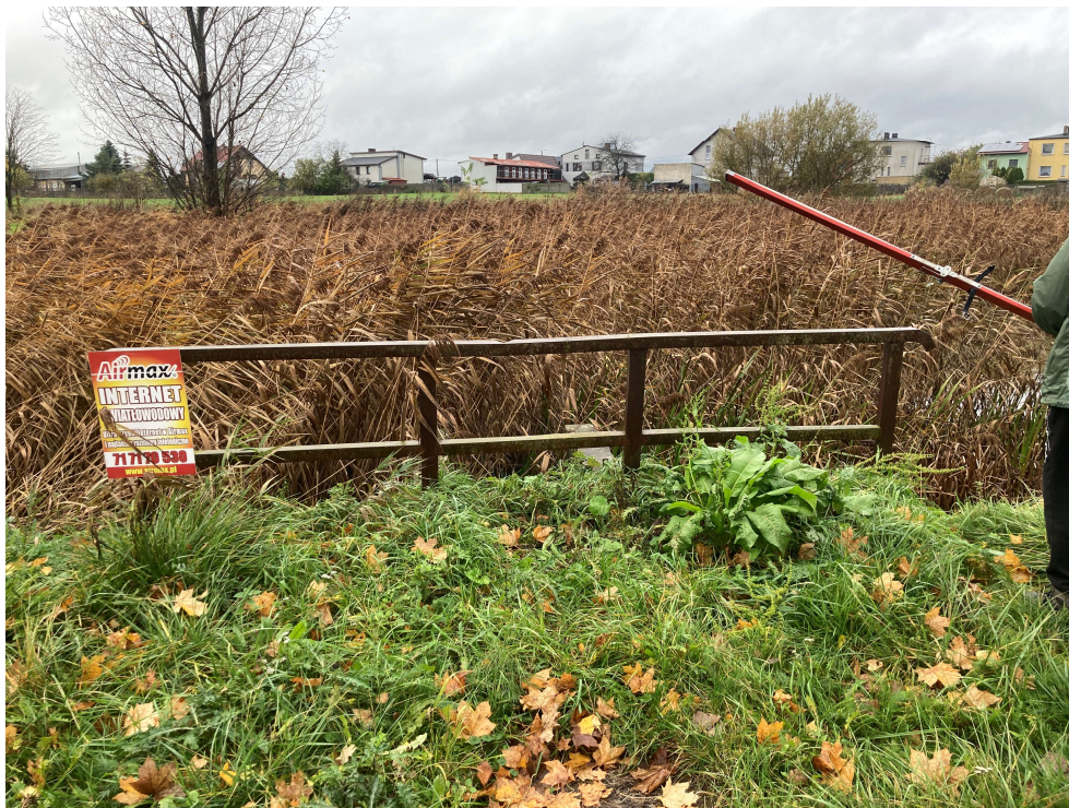
ZDJĘCIE NR 5. ZABEZPIECZENIE MNICHA BARIERKĄ STALOWĄ.
