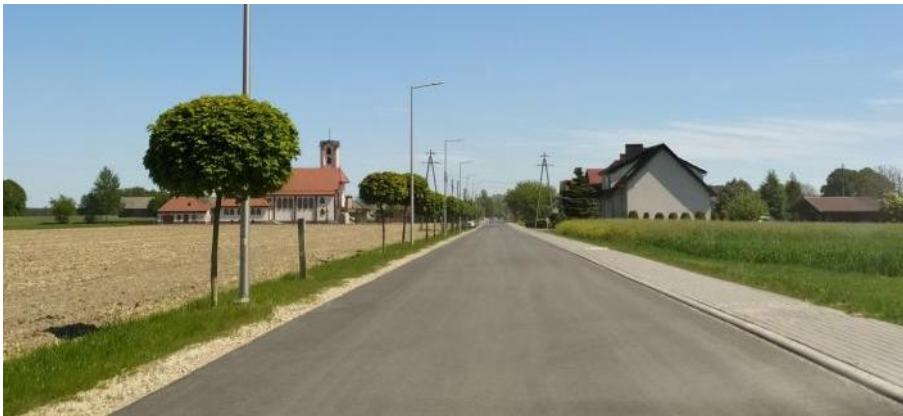
Zdjęcie: Przebudowany odcinek ul. Lompy w Wędzinie
