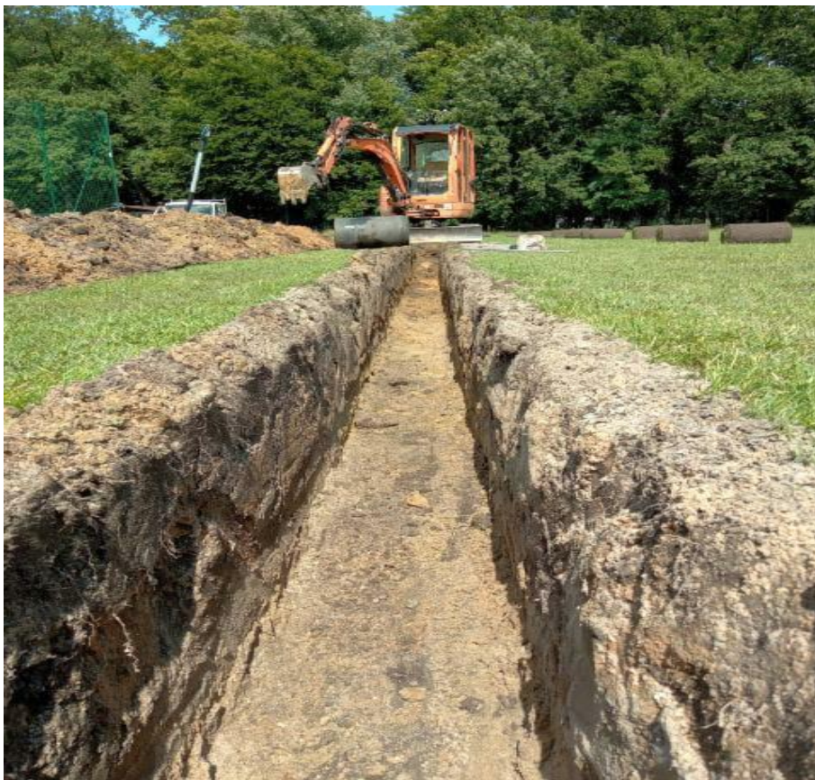
Zdjęcie: Zagospodarowanie terenu boiska sportowego w sołectwie Sieraków Śląski poprzez wykonanie odwodnienia
