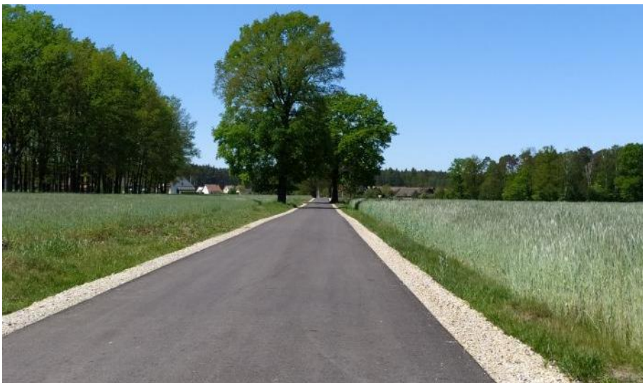
Zdjęcie: Przebudowana ulica boczna od ul. Szyszków w Sierakowie Śląskim
