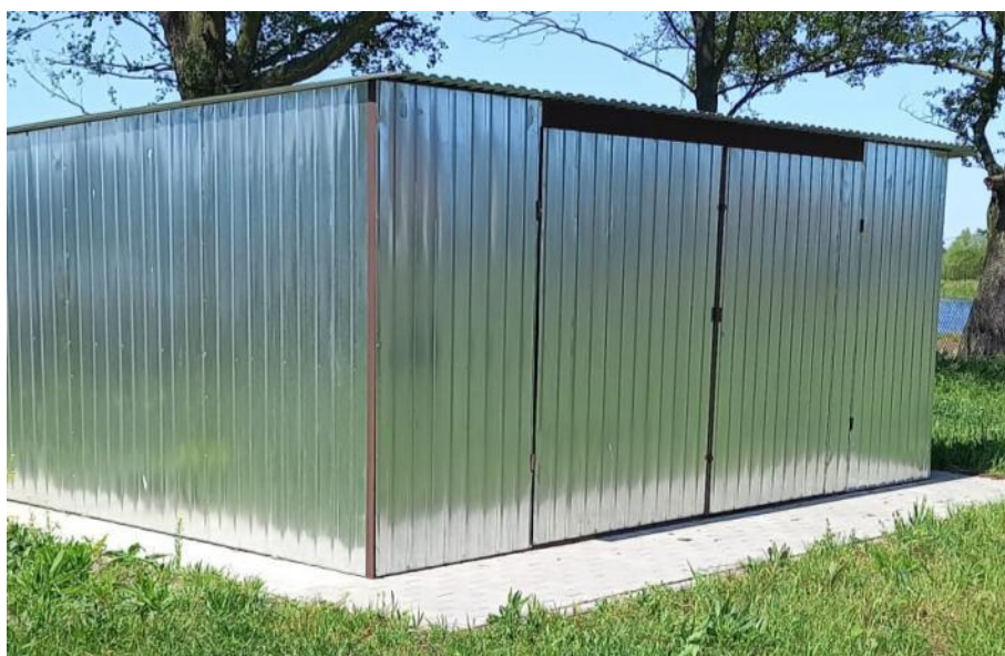
Zdjęcie: Garaż blaszany wraz z montażem oraz przygotowaniem terenu pod garaż dla sołectwa Panoszów
