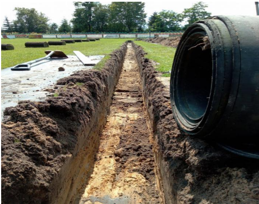
Zdjęcie: Zagospodarowanie terenu boiska sportowego w sołectwie Sieraków Śląski poprzez wykonanie odwodnienia
