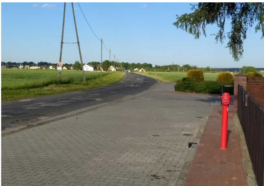
Zdjęcie: Sieraków Śląski odcinek ul. Wyzwolenia na którym wykonano rozbudowę sieci wodociągowej i kanalizacyjnej
