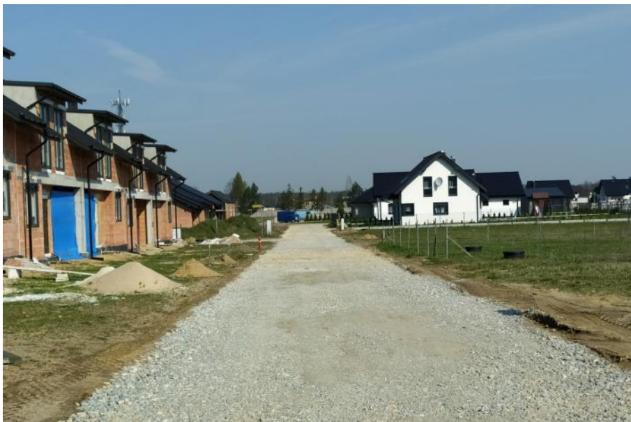
Zdjęcie: Nawierzchnia z tłucznia po wykonaniu robót budowlanych na nowy osiedlu pomiędzy ul. Lipową a linią lasu w Ciasnej
