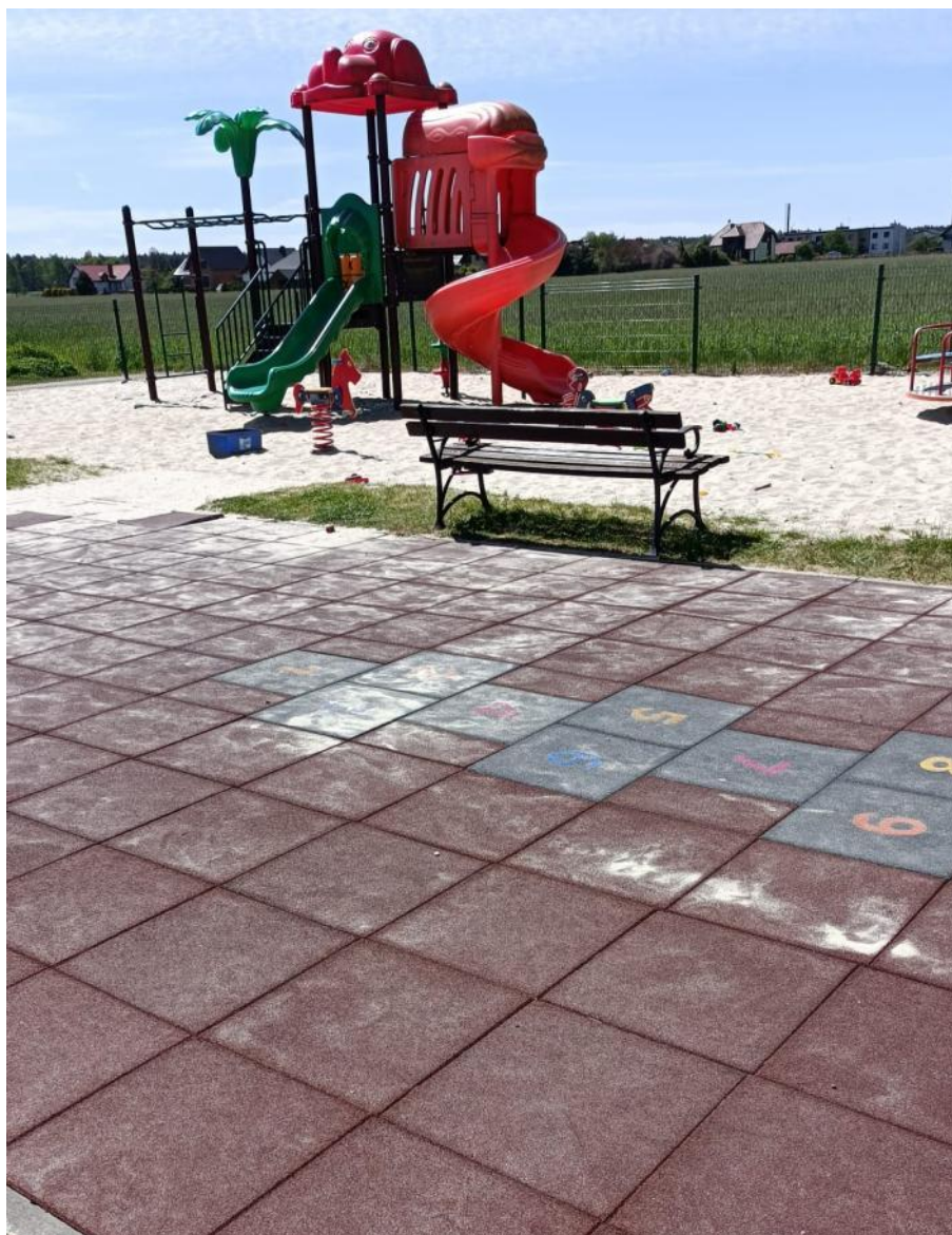
Zdjęcie: Nawierzchnia gumowa wraz z montażem na plac zabaw przy ul. Twardocha w Ciasnej
