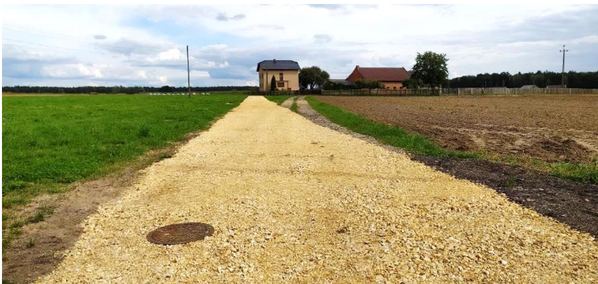
Zdjęcie: przyłącze kanalizacyjne w ul. Polnej w Zborowskim
