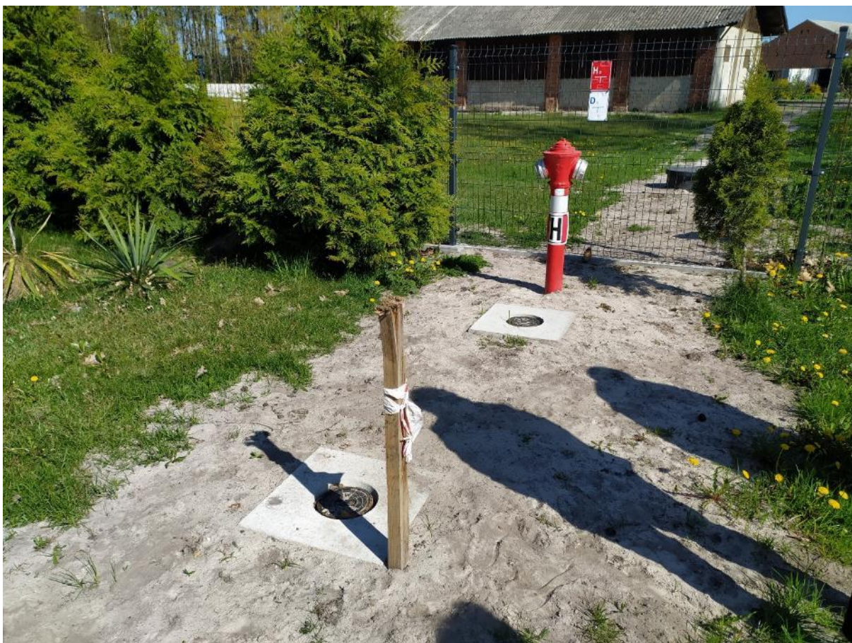
Zdjęcie: Wykonane zasuw i hydrant sieci wodociągowej w sięgaczu ul. Brzezinkowe w Glinicy
