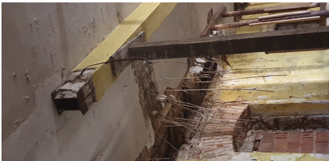
Zdj. 6 ( Zerwanie belki wspierającej antresolę po zawaleniu się słupa i stropu)
