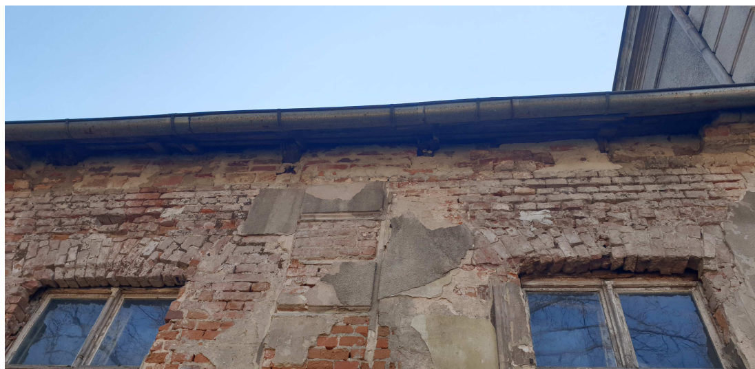
Zdj.1 (Uszkodzone górne części ścian elewacji północnej)
