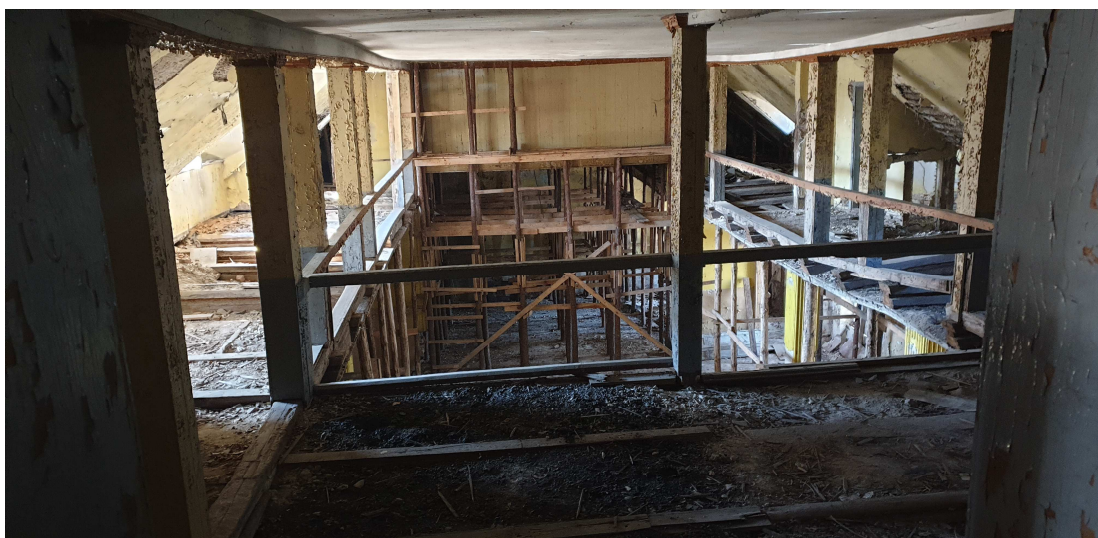
Zdj. 3 (Uszkodzona konstrukcja dachu i stropu segmentu wschodniego wraz ze stemplami podpierającymi przed zawaleniem.)
