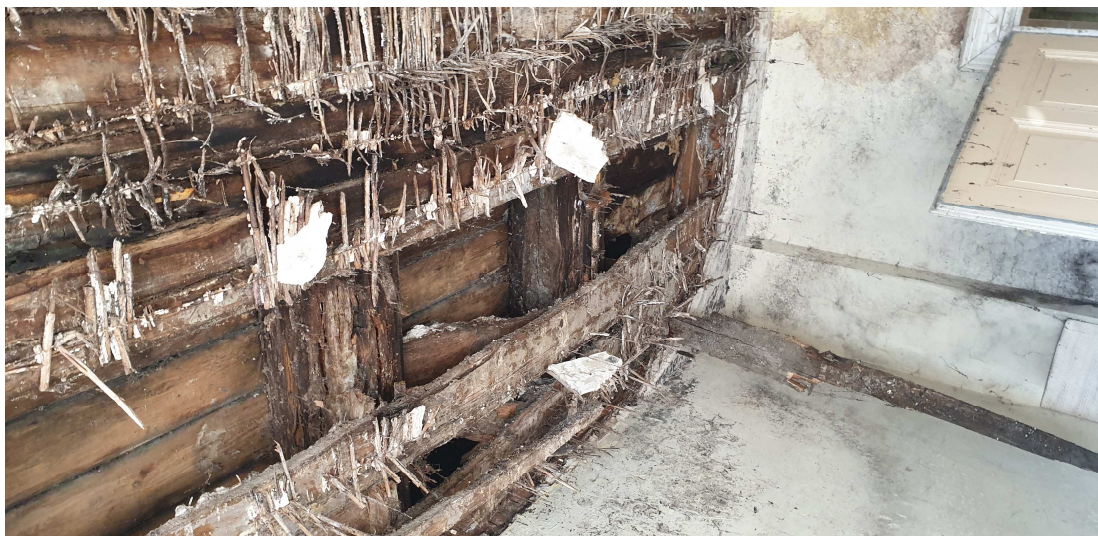
Zdj. 2 ( Zniszczone belki stropu poddasza segmentu zachodniego)
