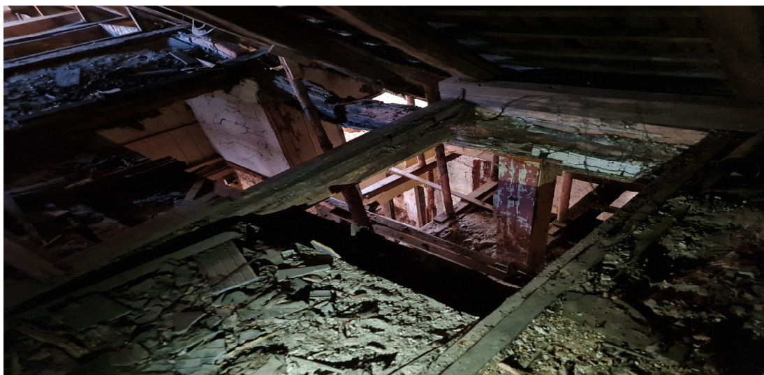
Zdj. 6 ( Zerwanie belki wspierającej antresolę po zawaleniu się słupa i stropu)
