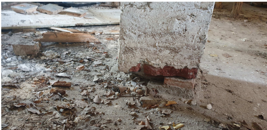
Zdj. 4 (Uszkodzenia podstaw słupów antresoli oraz zawalony strop piwnicy)
