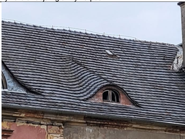
Dachówka w kolorze antracytu, układ podwójny na głównym korpusie i bocznych skrzydłach .
