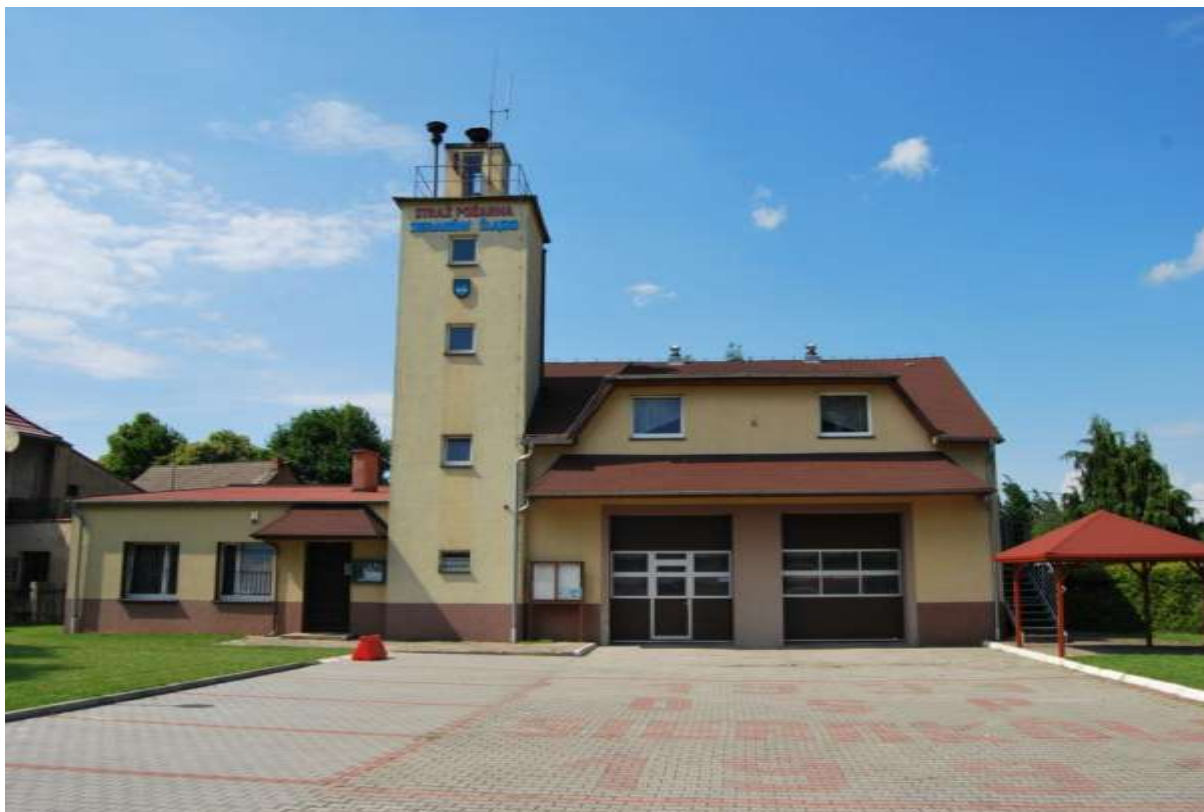
Foto: Budynek remizy OSP w Sierakowie Śląskim
