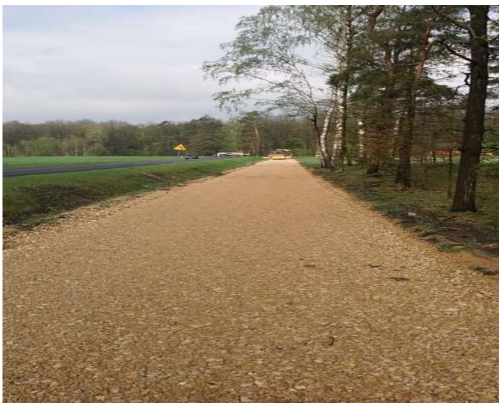
Foto: Podbudowa przygotowana do układania nawierzchni bitumicznej drogi rowerowej
