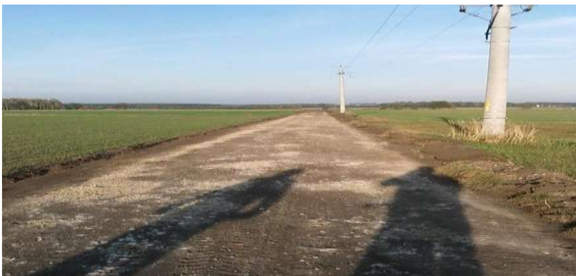
Foto: Ulica Osiedlowa w Molnej przed przebudową.
