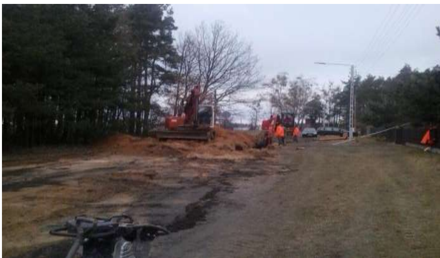
Foto: Realizacja kanalizacji w miejscowości Zborowskie ul. Polna.
