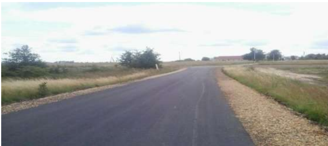
Foto: Ulica Boczna po przebudowie
