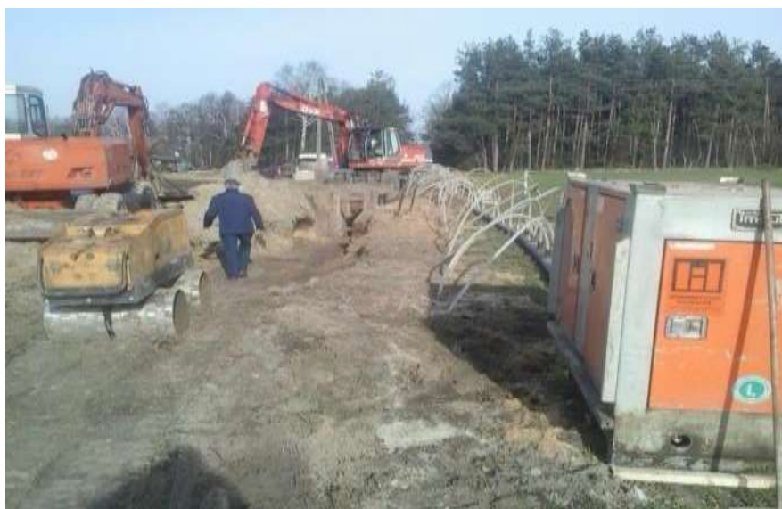
Foto: Realizacja kanalizacji w miejscowości Zborowskie ul. Borkowa
