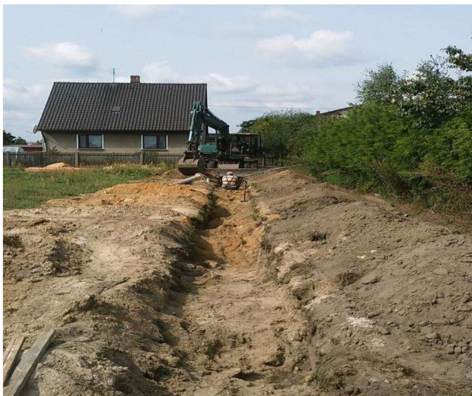
Foto: Realizacja kanalizacji w miejscowości Ciasna ul. Nowy Dwór
