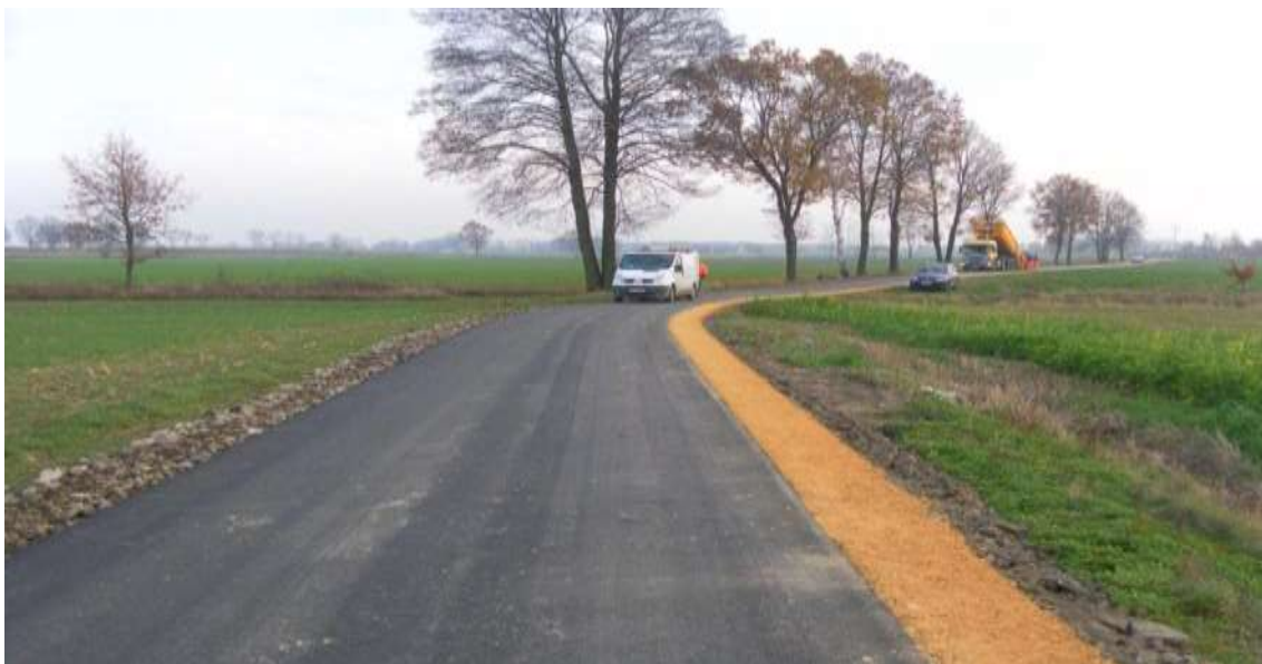
Foto: Realizacja robót na siegaczu ul. Wiejskiej w Molnej
