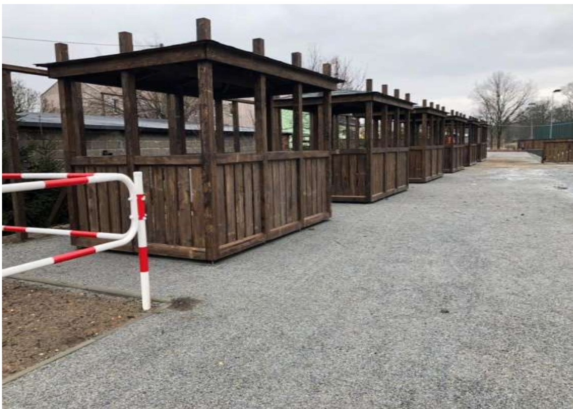
Foto: Elementy malej architektury
