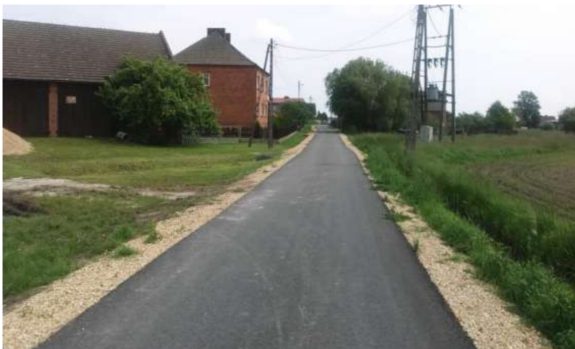
Foto: Ulica Polna w Jeżowej po przebudowie.
