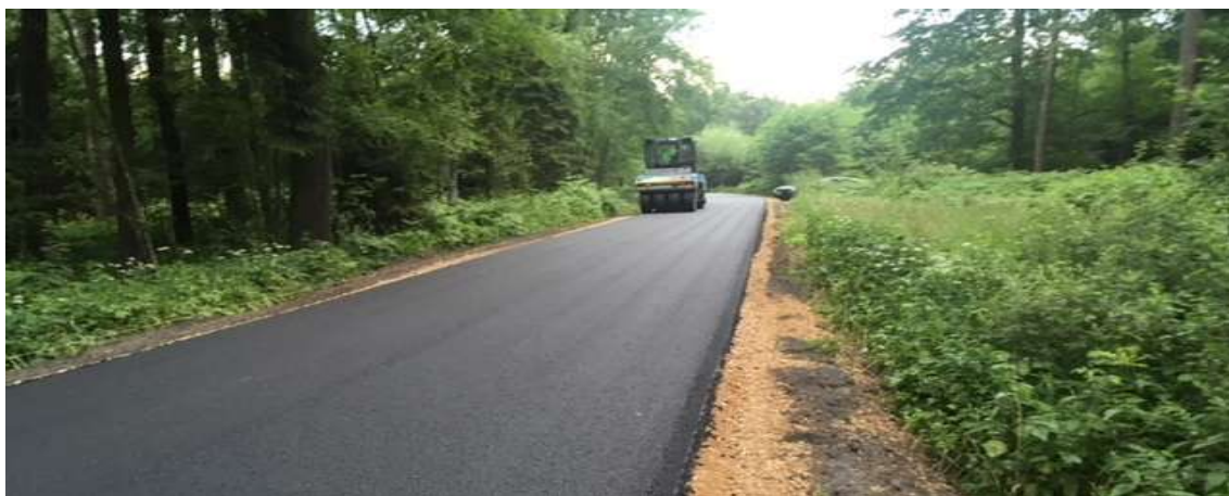
Foto: Realizacja nawierzchni bitumicznej ul. Leśnej w Ciasnej
