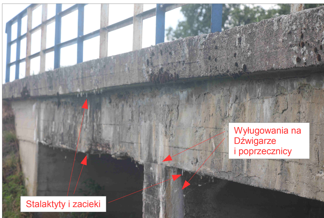
Fot. 2 – Widok na skrajny dźwigar od strony GW
