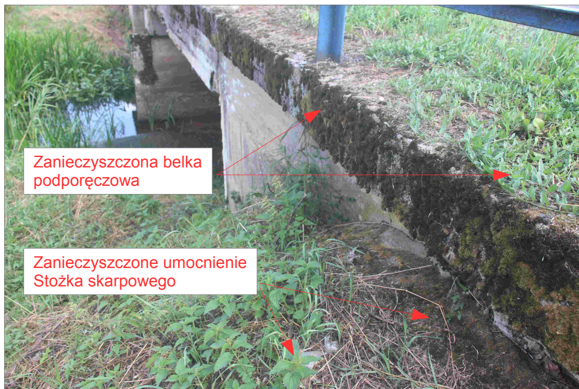
Fot. 5 – Widok na stożek skarpowy i belkę podporęczową od strony dolnej wody (DW)
