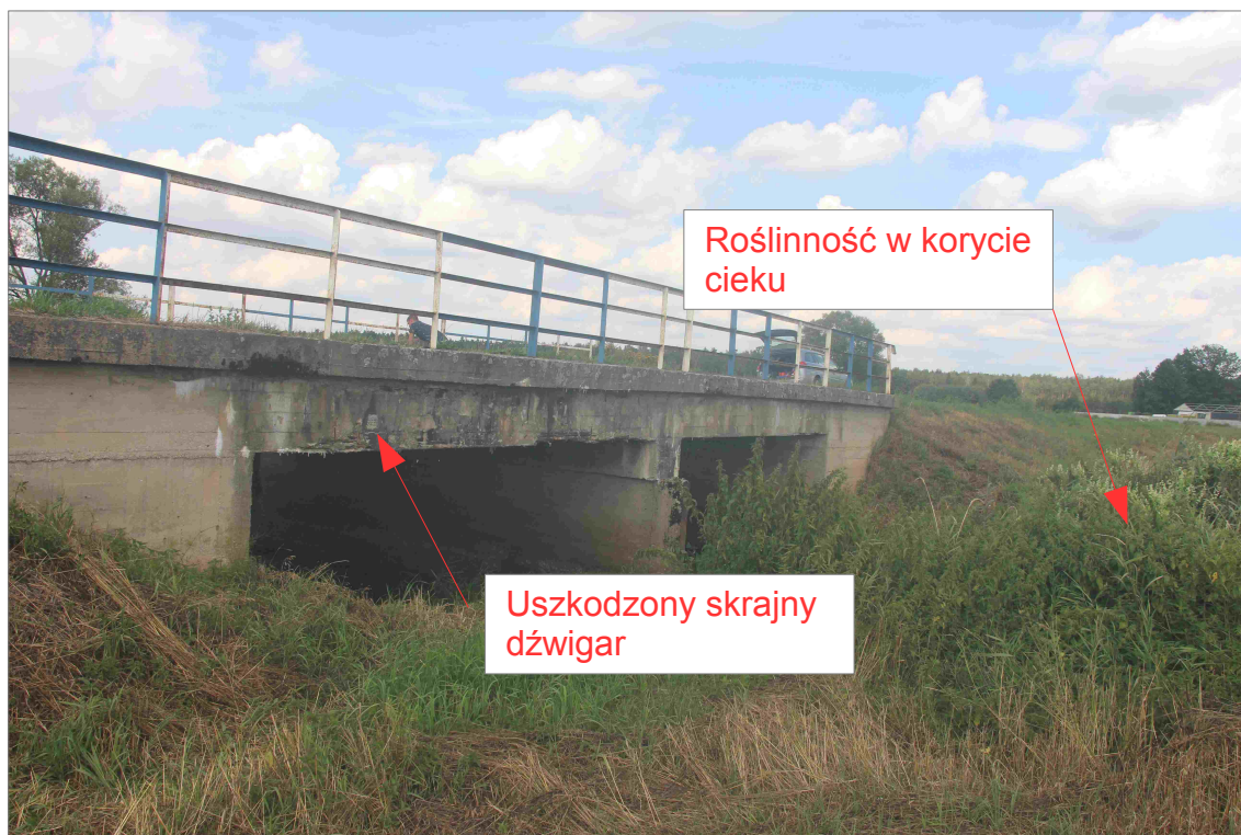
Fot. 1 – Widok od strony Górnej Wody (GW)
