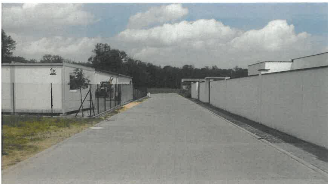
Foto: Sięgacz ul. Zjednoczenia do starego ujęcia wody w Ciasnej po przebudowie.
