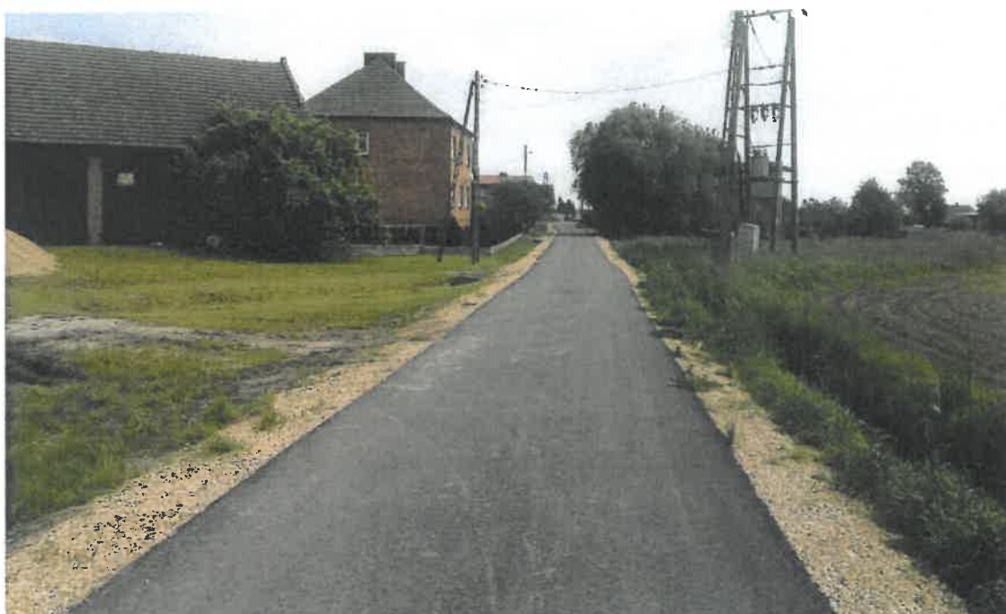
Foto: Ulica Polna w Jeżowej po przebudowie.
