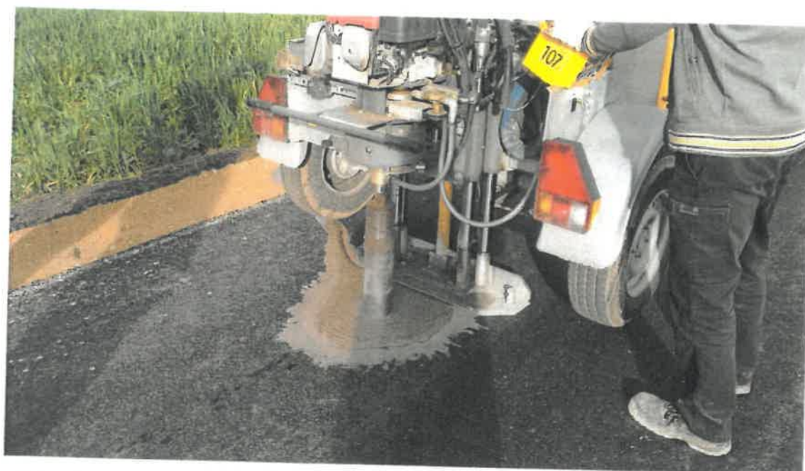
Foto: Badania nawierzchni ul. Osiedlowej w Molnej.
