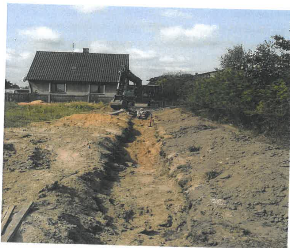
Foto: Realizacja kanalizacji w miejscowości Ciasna ul. Nowy Dwór
