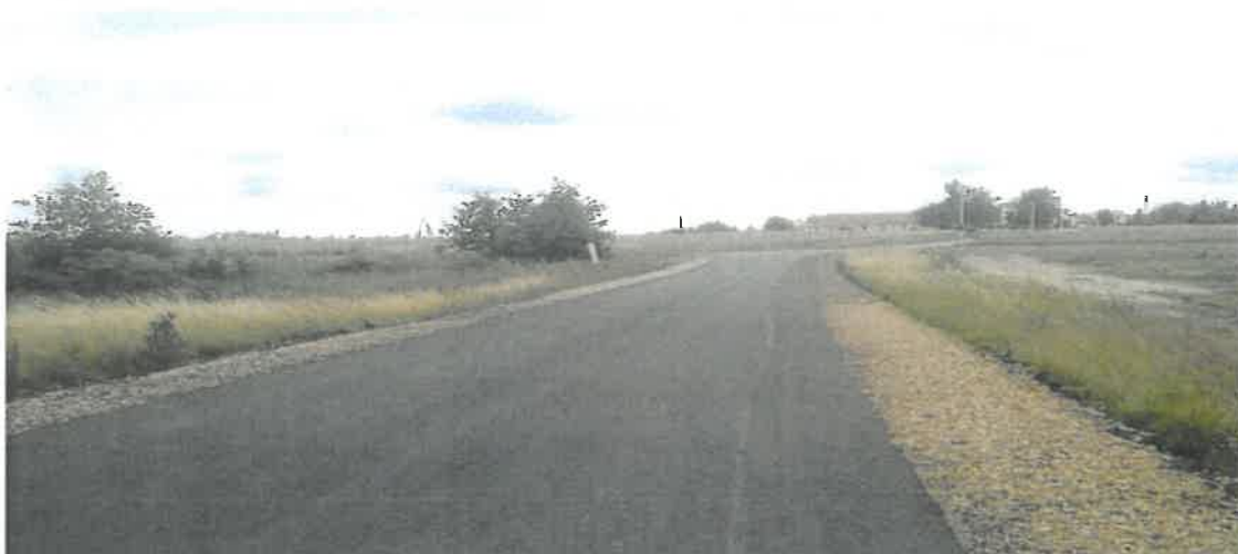
Foto: Ulica Boczna po przebudowie
