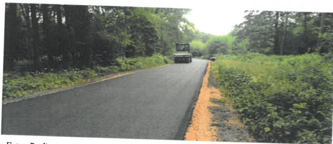
Foto: Realizacja nawierzchni bitumicznej ul. Leśnej w Ciasnej
