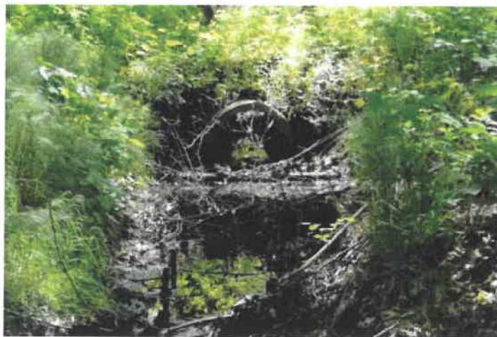
przepust z rury betonowej Ø 60 cm
