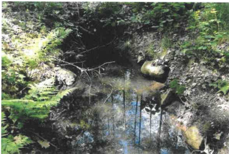
kamienne umocnienia brzegów rowu przy wylotach z przepustu
