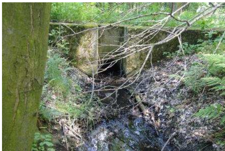
Ciek odprowadzający wodę z mnichem
