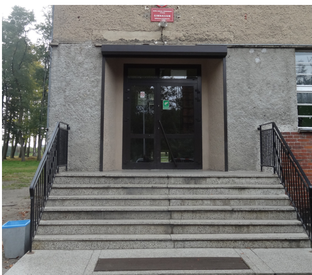
Fotografia 2 - widok ogólny schodów
