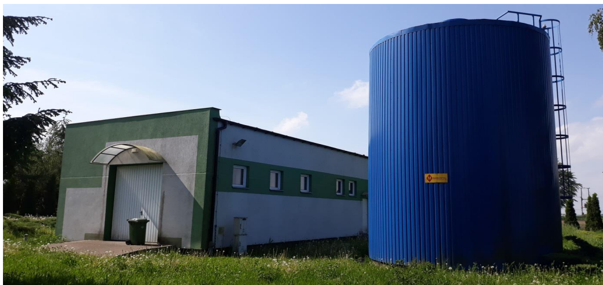
Stacja Uzdatniania Wody Chojno
