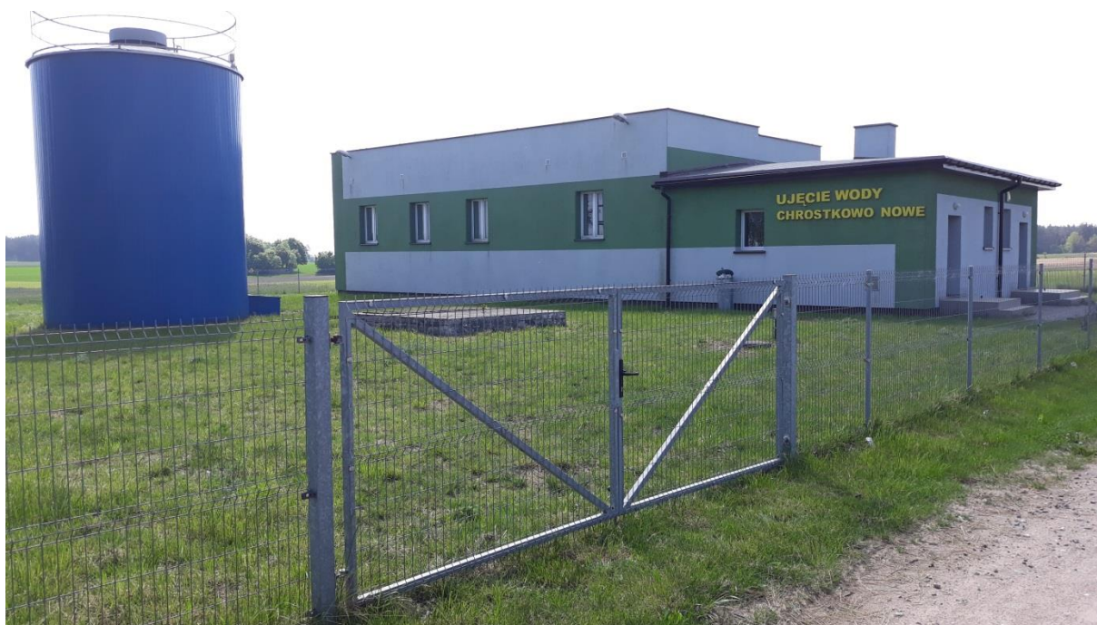
Stacja Uzdatniania Wody Chrostkowo Nowe
