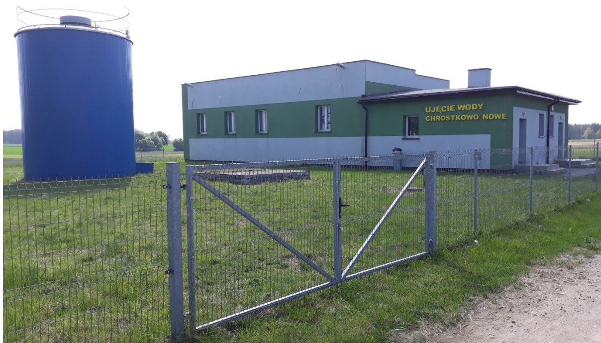
Stacja Uzdatniania Wody Chrostkowo Nowe
