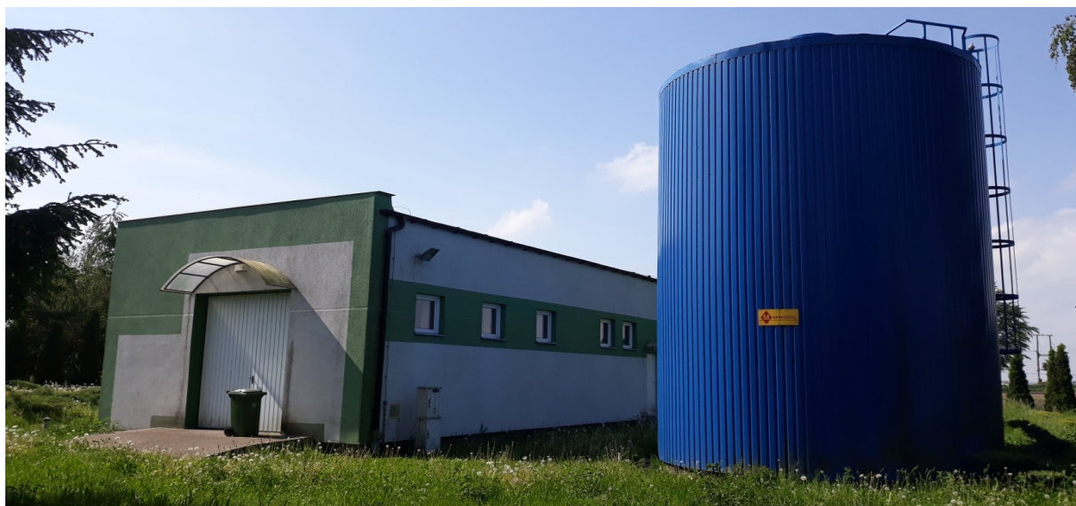
Stacja Uzdatniania Wody Chojno
