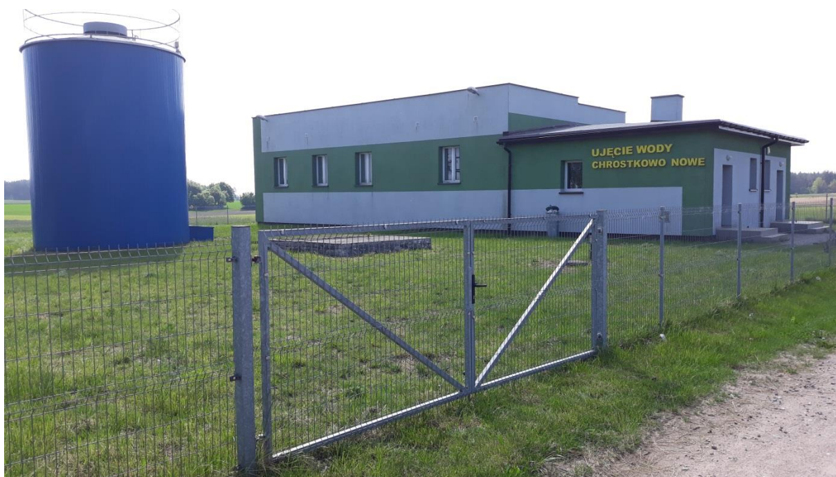
Stacja Uzdatniania Wody Chrostkowo Nowe
