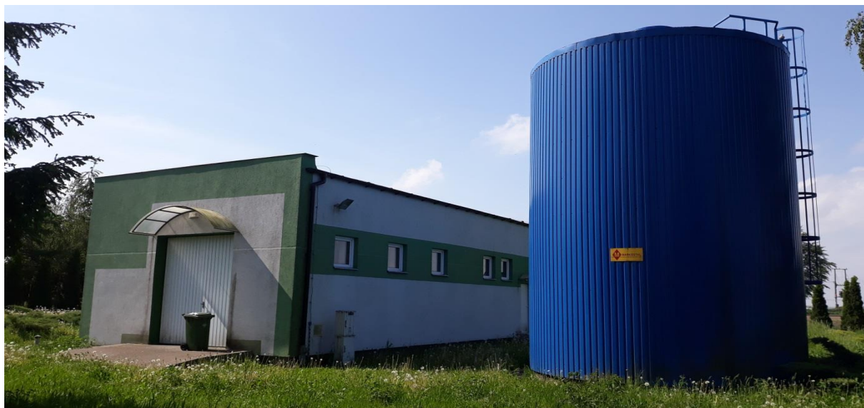
Stacja Uzdatniania Wody Chojno
