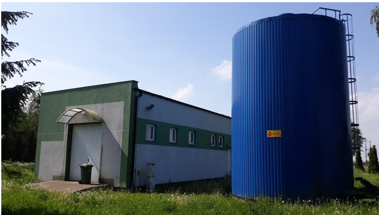
Stacja Uzdatniania Wody Chojno
