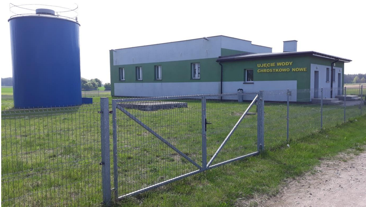
Stacja Uzdatniania Wody Chrostkowo Nowe
