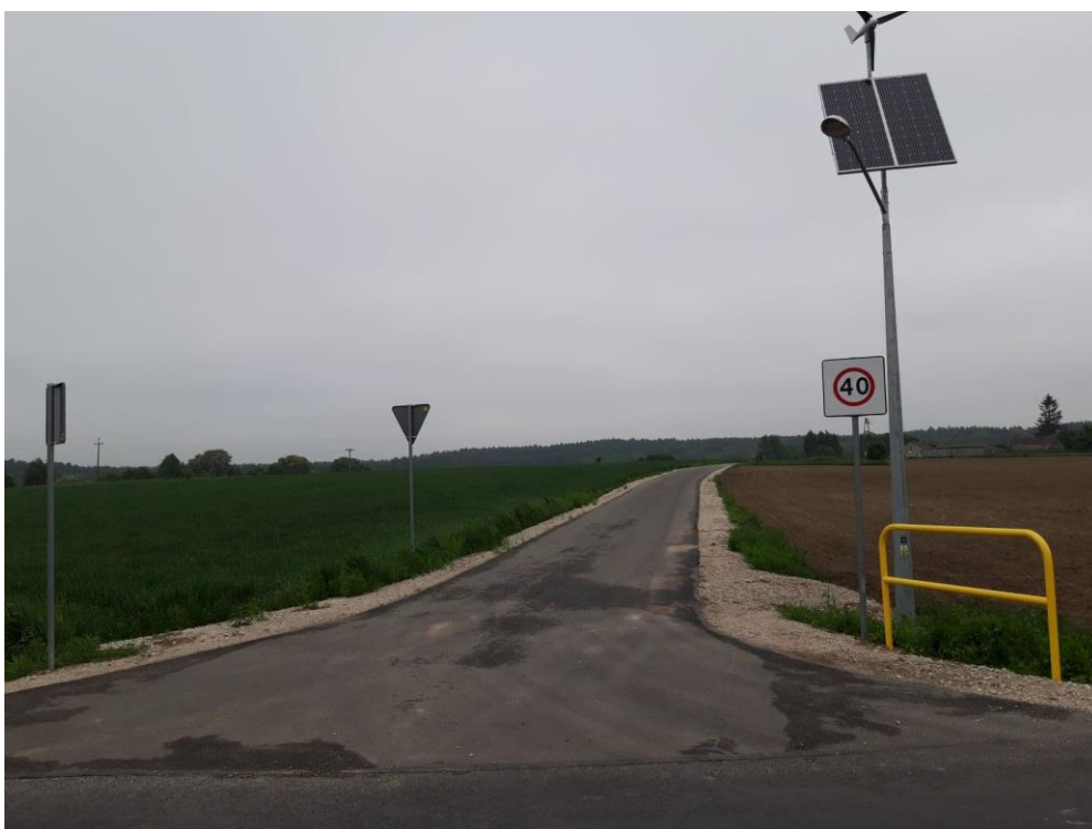
Droga w Chojnie prowadząca przez teren rolniczy wraz z zamontowaną na skrzyżowaniu lampą hybrydową.
