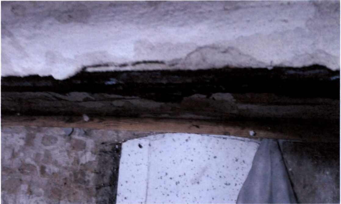
Z1. Silnie skorodowana belka stropu w pomieszczeniu nr 2
