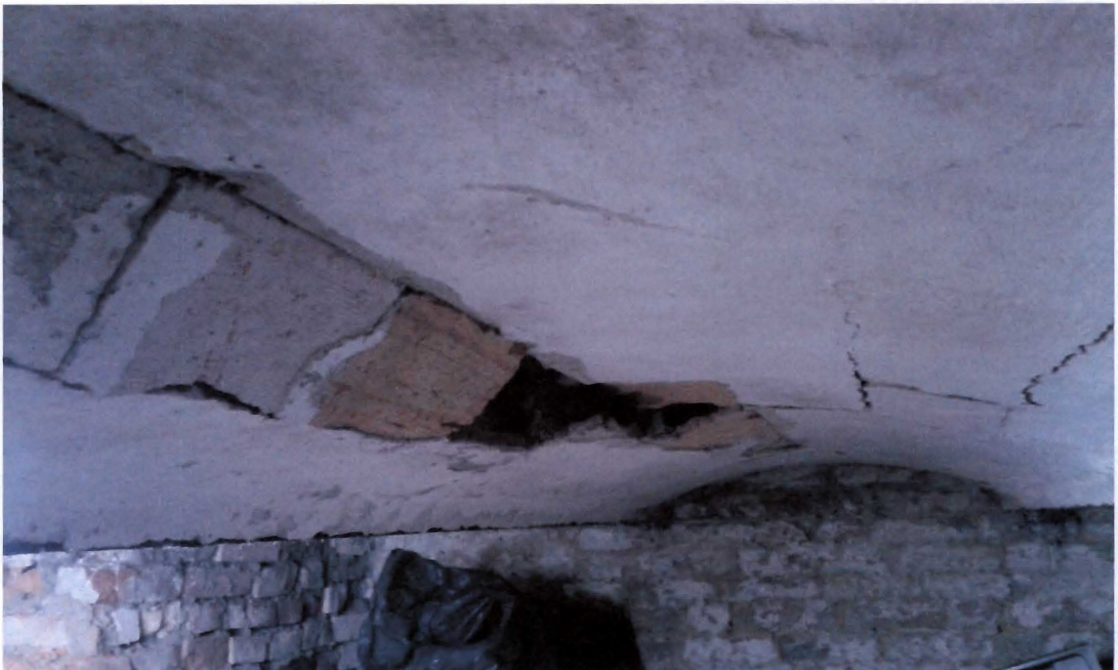
Z2. Uszkodzenia wypełnienia stropu od krystalizujących produktów korozji
