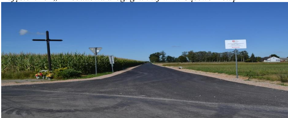
Zdjęcie nr 6- „Przebudowa drogi gminnej w m. Gąsewo – etap I”
