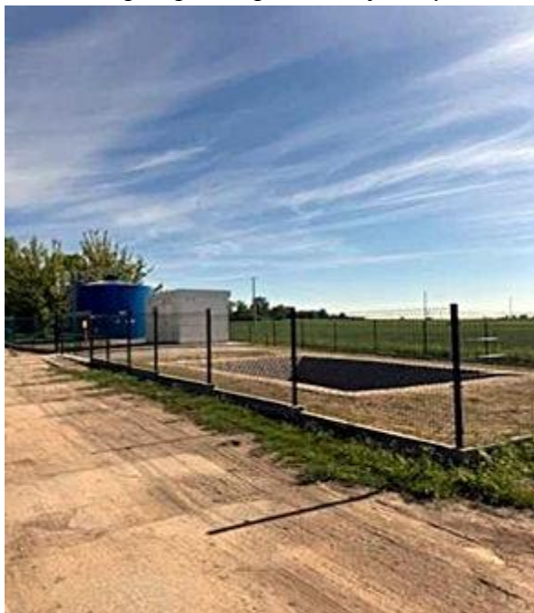
Zdjęcie nr 13 – „Budowa pompowni pośredniej wody w Borowicach”
