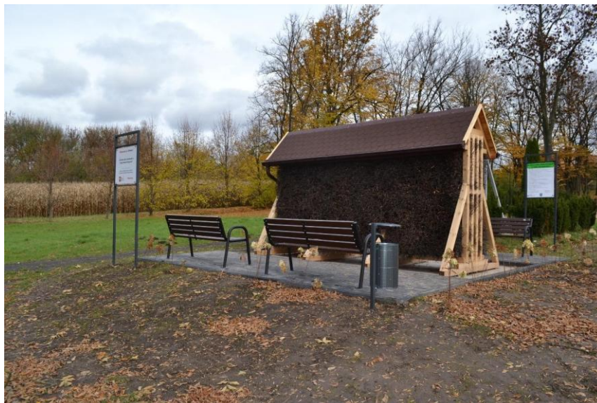
Zdjęcie nr 2 - „Budowa tężni solankowej w miejscowości Bodzanów”
